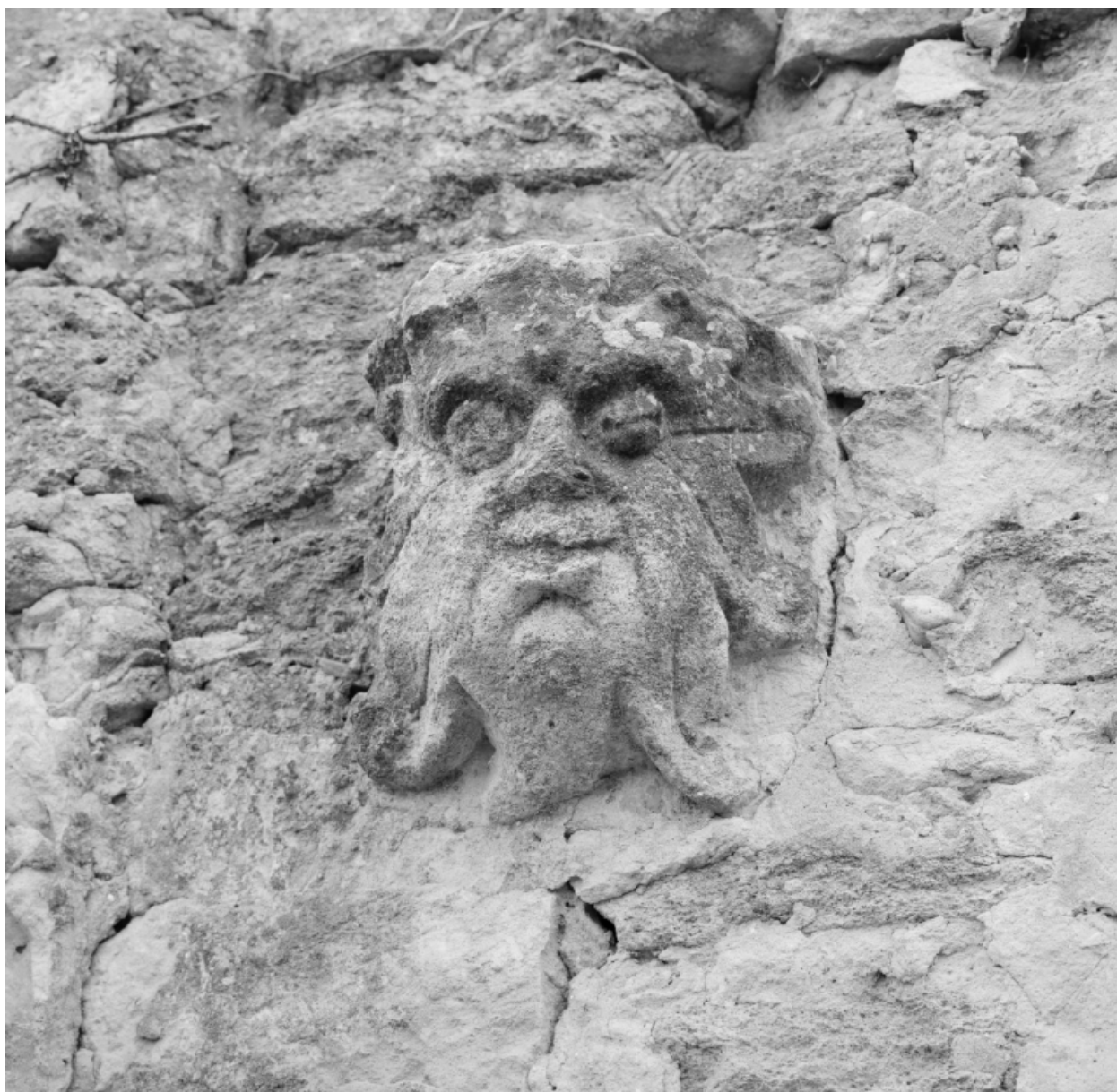
Mur de soutènement, détail : mascaron.
