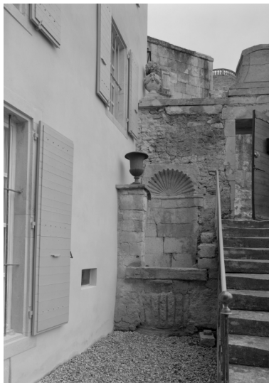
Escalier extérieur donnant accès à la cour et puits avec niche en coquille, au revers du portail d'entrée.
