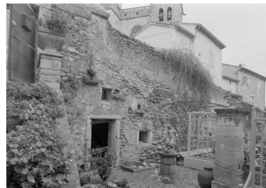
Mur de soutènement de la rue Saint-Sauveur, sur le jardin, avec dépendances.
