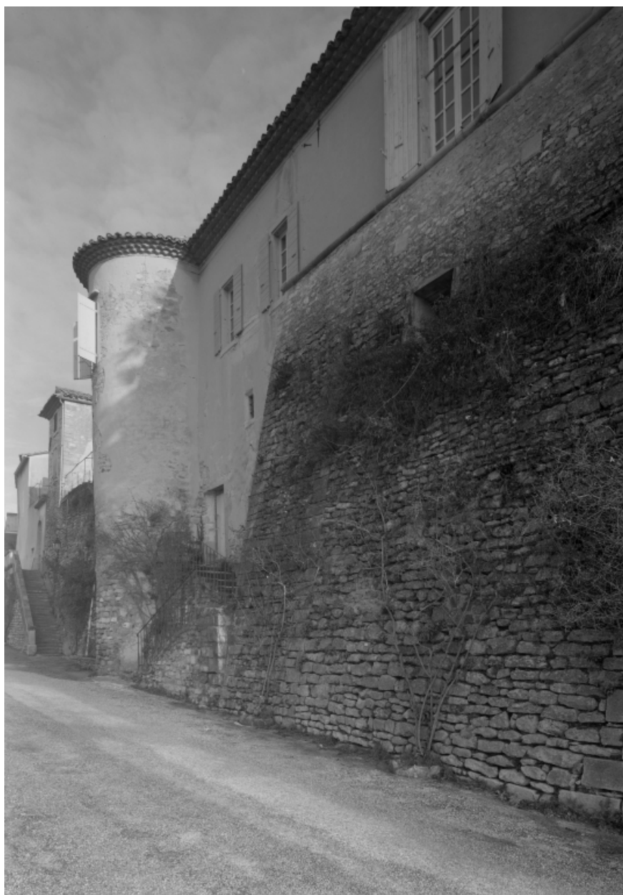
Porte d'entrée du corps de logis, couverte d'un arc déprimé et d'un encadrement architectural.
