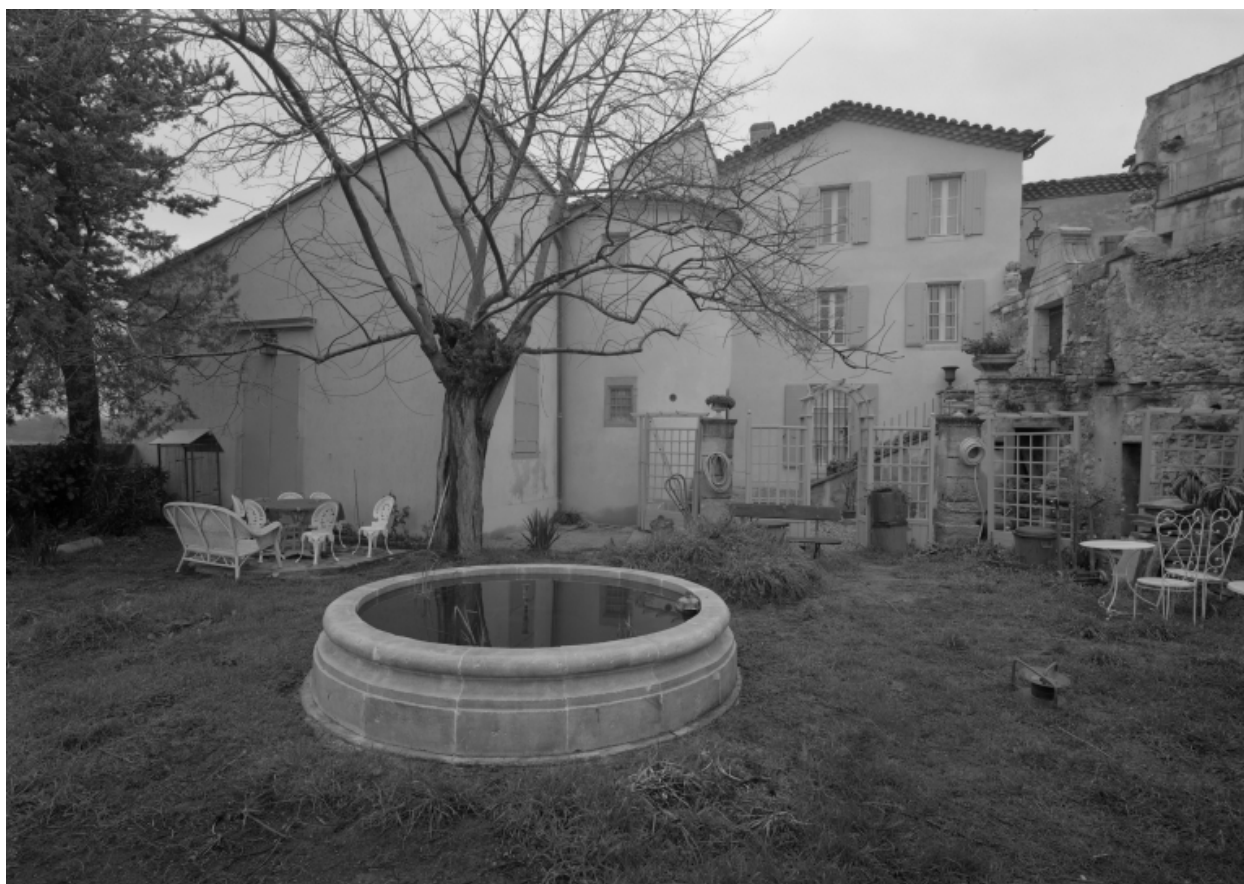
Vue d'ensemble des façades sur jardin.
