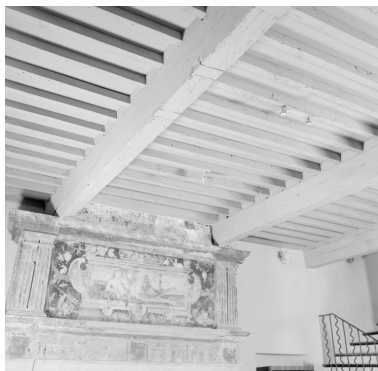
Vue partielle de la salle : plafond à solives et hotte de cheminée. Phot. Eric Dessert IVR82_20012600115X
