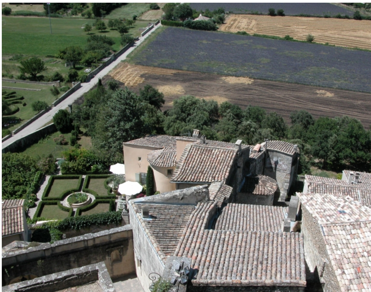
Vue prise depuis le château : la toiture du bâtiment et le jardin, après restauration.
