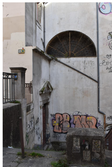
Vue extérieure du transept ouest depuis le passage Thiaffait Phot. Thierry Monnet IVR84_20256900332NUCA
