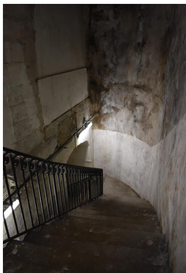
Vue de l'escalier conduisant de la chapelle Ouest du chœur depuis le 1er étage Phot. Caroline Guibaud IVR84_20256900337NUCA
