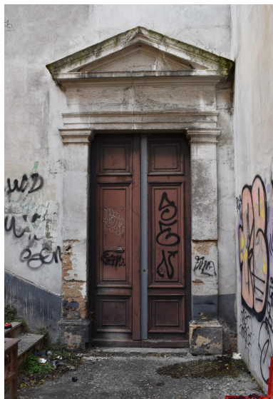
Vue extérieure de la porte conduisant à la tribune ouest depuis le passage Thiaffait Phot. Caroline Guibaud IVR84_20256900342NUCA
