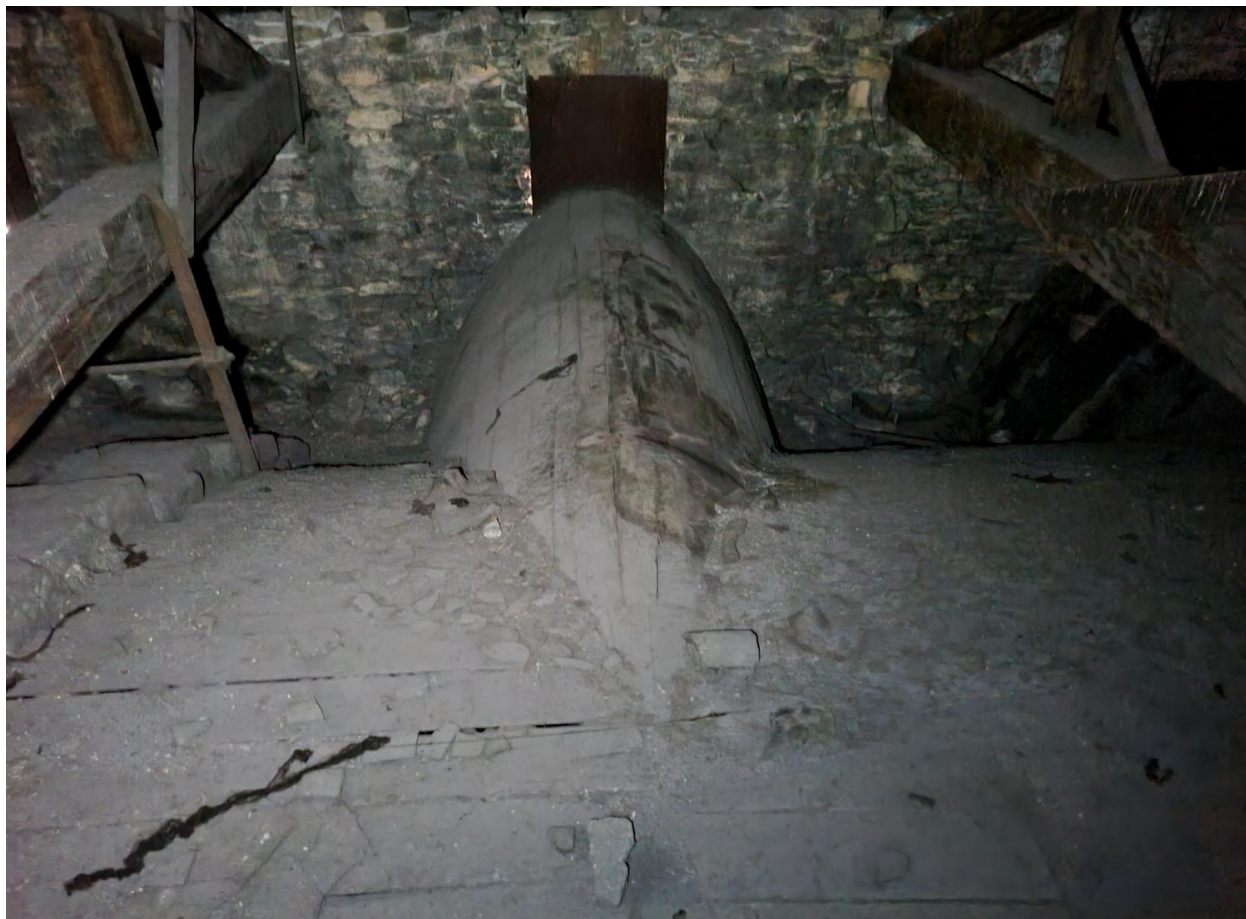
Vue des combles, vue de l'extrados de la voûte couvert de bois et vue partielle de la charpente
