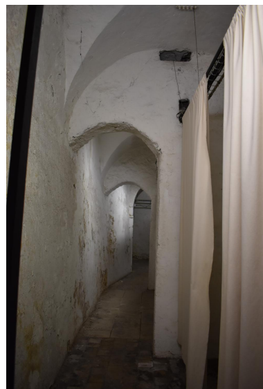
Vue du passage située au 1er étage à l'arrière du chevet Phot. Caroline Guibaud IVR84_20256900336NUCA
