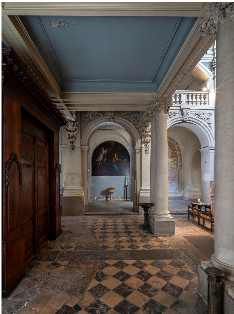
Vue de la première travée depuis le bas côté ouest
