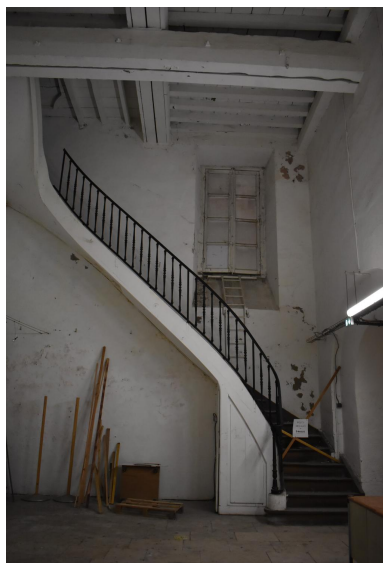
Vue d'ensemble de l'escalier quart tournant situé au 1er étage, conduisant à l'ancien logement de l'abbé Phot. Caroline Guibaud IVR84_20256900335NUCA
