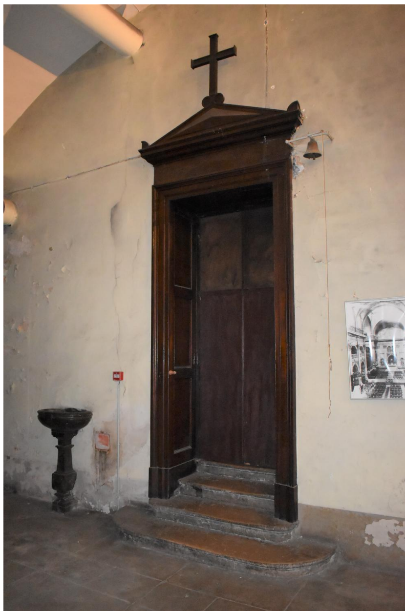
Porte d'accès à la sacristie depuis la nef
