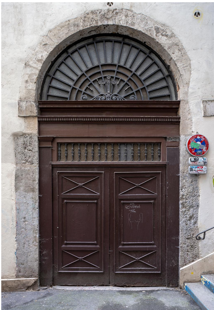
Porte latérale est côté passage Mermet donnant accès à la nef
