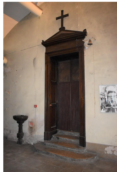
Porte d'accès à la sacristie depuis la nef Phot. Thierry Monnet IVR84_20256900328NUCA
