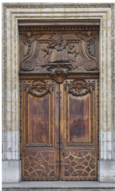
Vue d'ensemble de la porte principale Phot. Franck Trabouillet IVR84_20256900641NUCA
