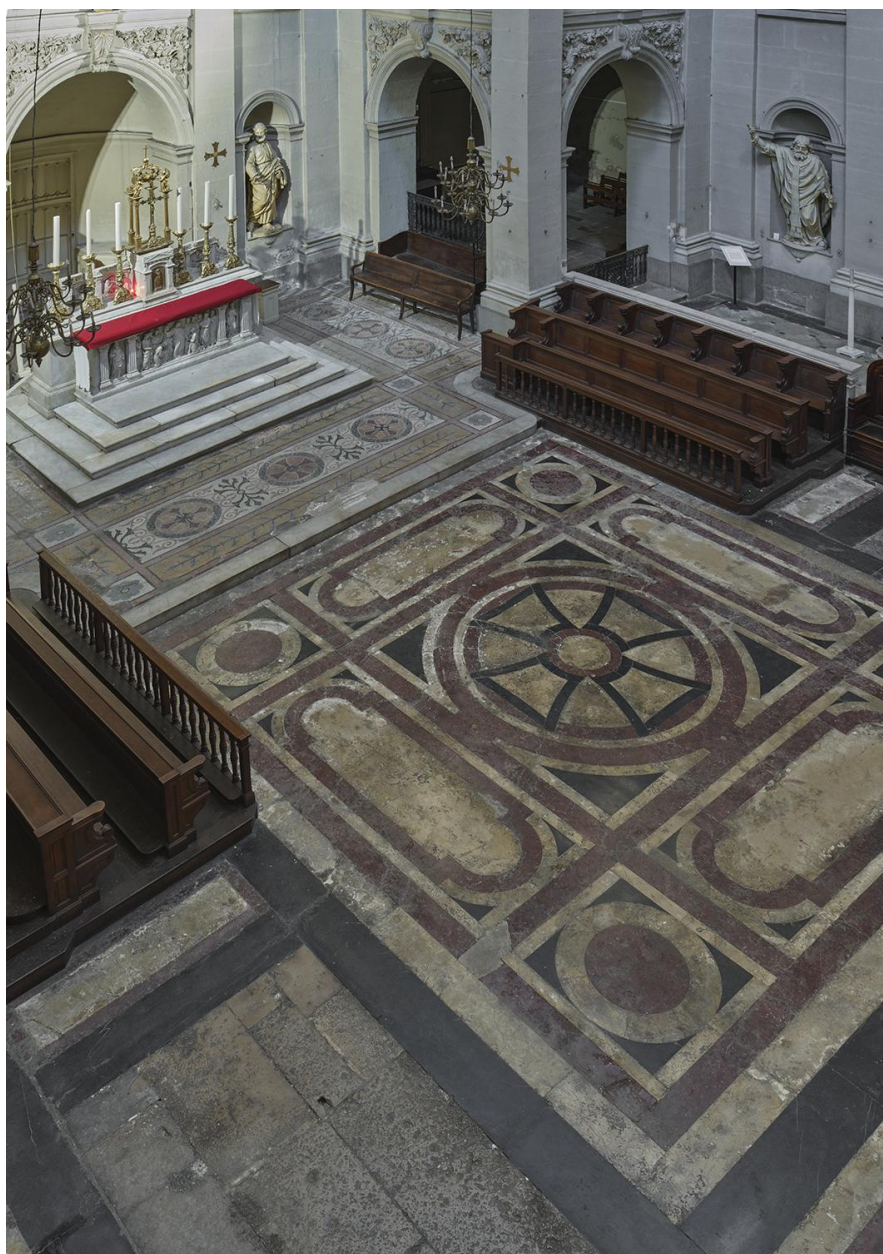
Vue d'ensemble du dallage de la croisée du transept, depuis la tribune du transept ouest
