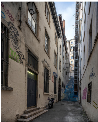
Vue partielle de l'élévation est et du passage Mermet Phot. Michel Pérès IVR84_20256900230NUCA
