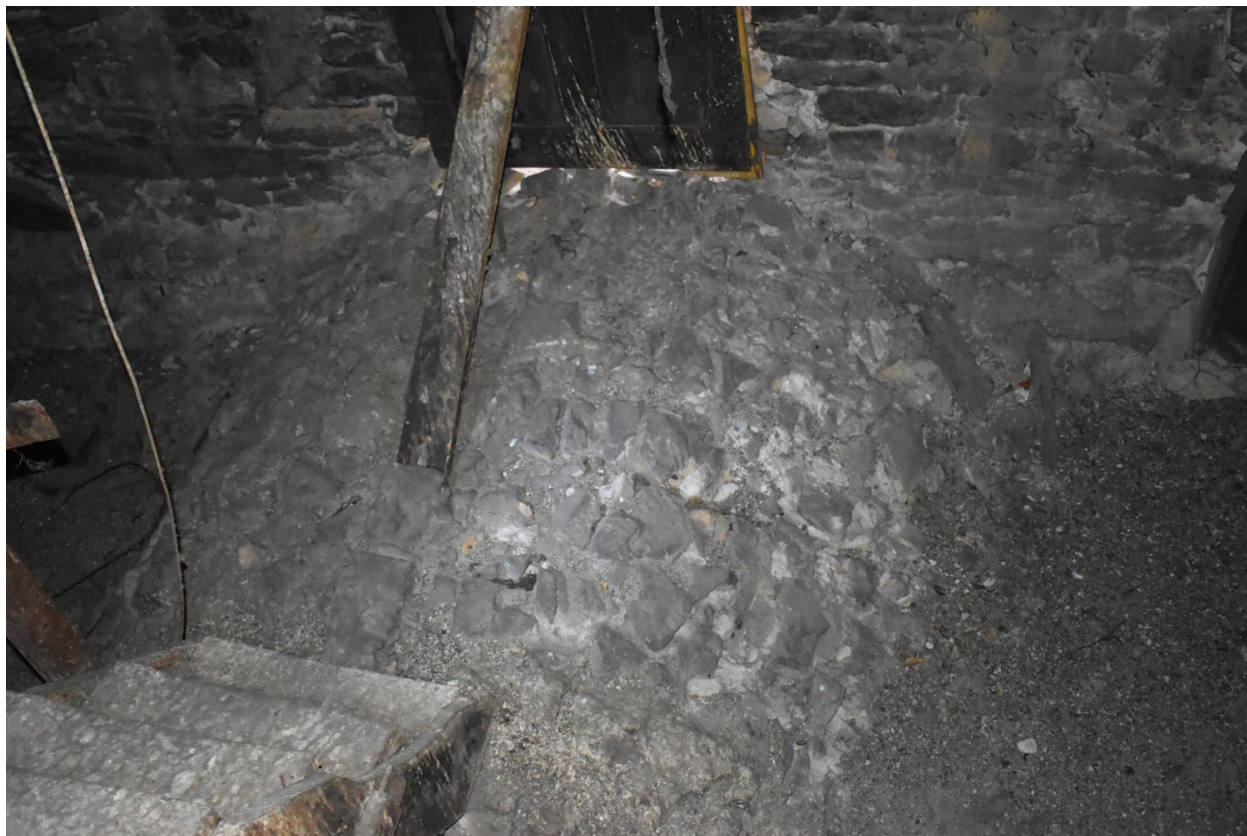
Vue des combles, détail de l'extrados de la voûte de la nef
