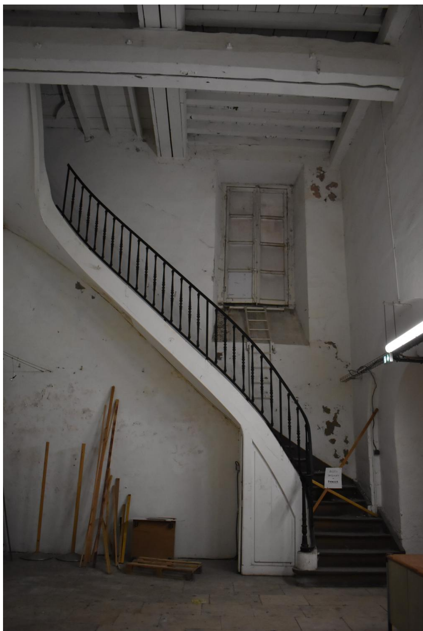
Vue d'ensemble de l'escalier quart tournant situé au 1er étage, conduisant à l'ancien logement de l'abbé
