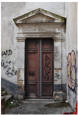
Vue extérieure de la porte conduisant à la tribune ouest depuis le passage Thiaffait
