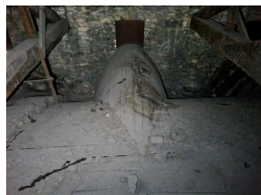
Vue des combles, vue de l'extrados de la voûte couvert de bois et vue partielle de la charpente Phot. Caroline Guibaud IVR84_20256900333NUCA
