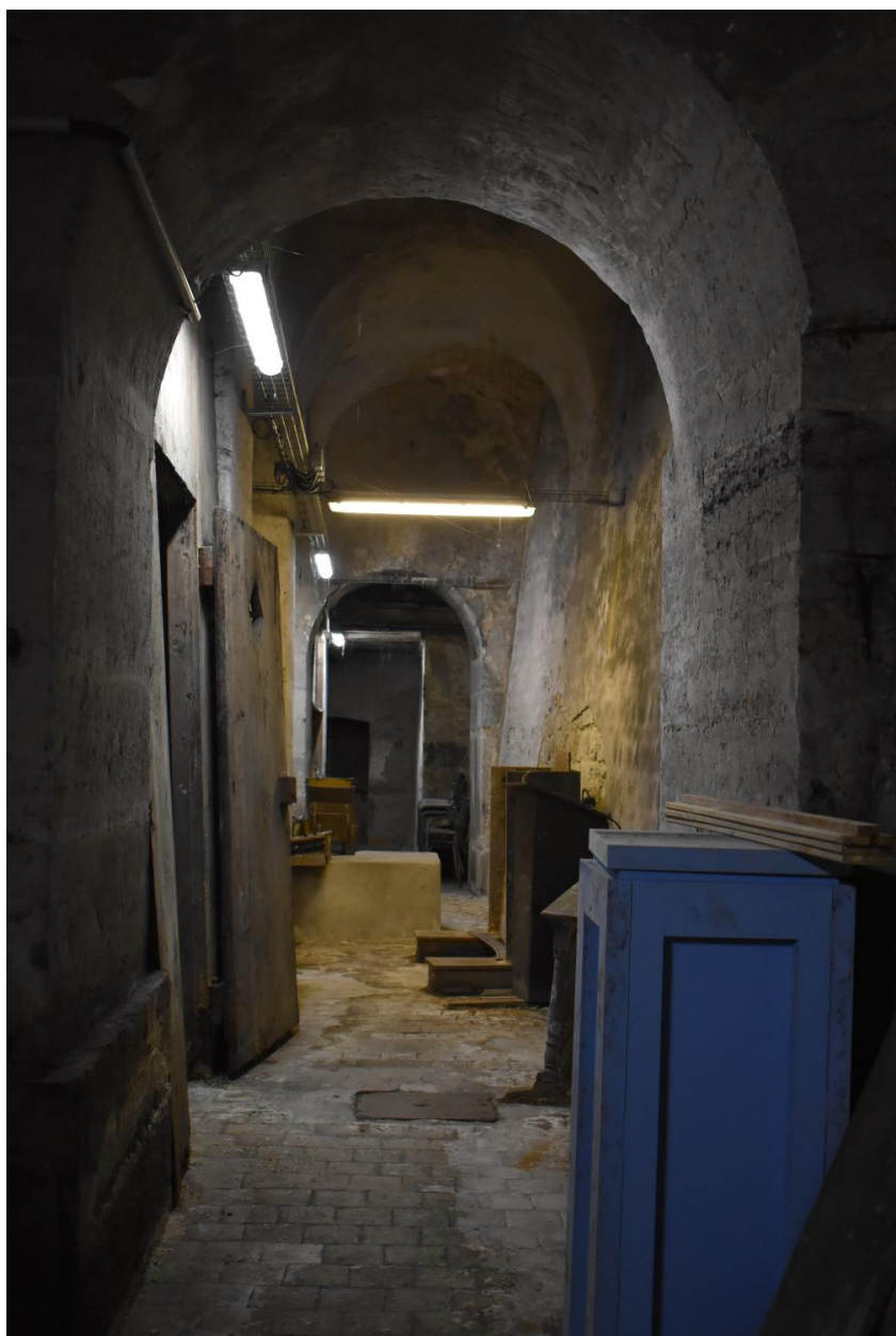
Vue du passage situé entre le chevet et les murs de soutènement
