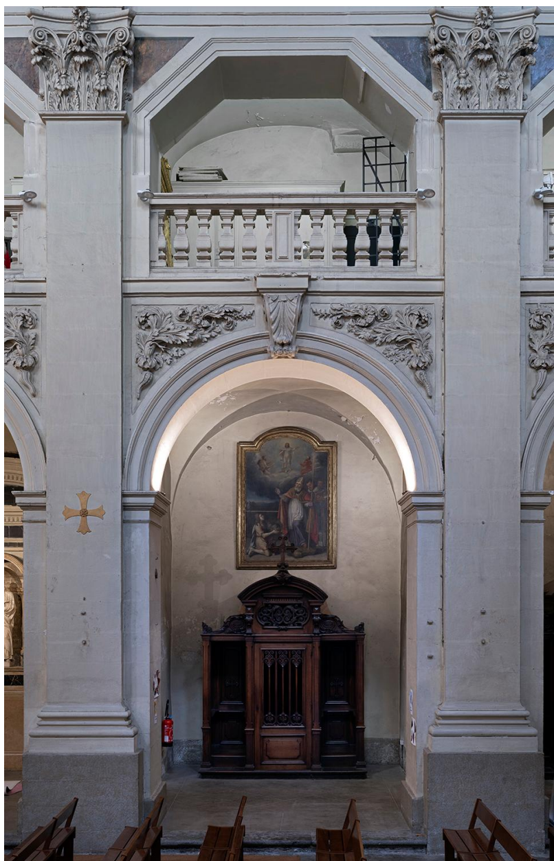
Elévation de la nef : ordre colossal corinthien, arc en plein cintre et tribune polygonale à trois pans
