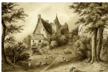
Vue est avant travaux Phot. Lionel Sauzade IVR84_20216300942NUCA
