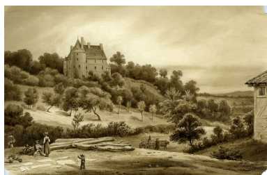
Vue sud avant travaux Phot. Lionel Sauzade IVR84_20216300941NUCA
