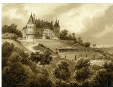
Vue sud après travaux Phot. Lionel Sauzade IVR84_20216300945NUCA
