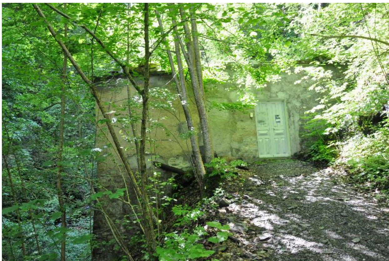
Vue de la centrale.
