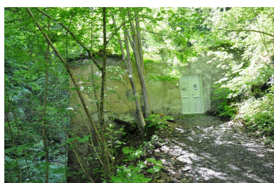
Vue de la centrale.
