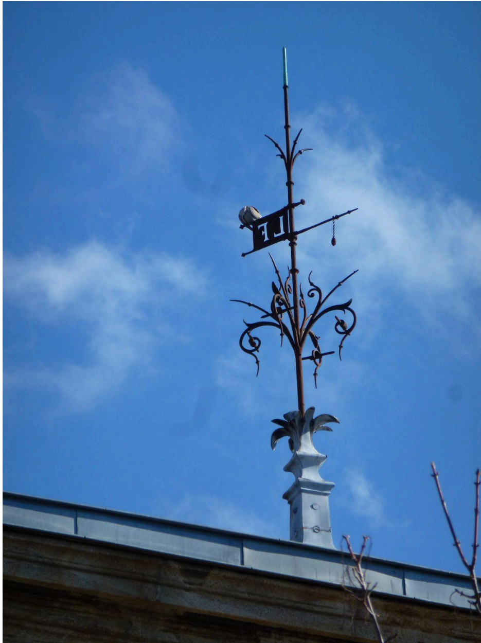
Girouette d'amortissement de l'avant-corps central de la façade d'entrée. On y lit un L et un F, pour "lycée de filles" probablement.
