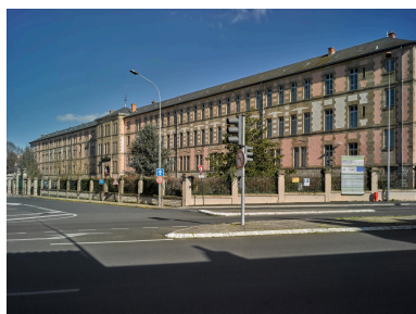
Façade sur la rue du 8-Mai. Orientée à l'est. Phot. Christian Parisey IVR84_20200300068NUC4A
