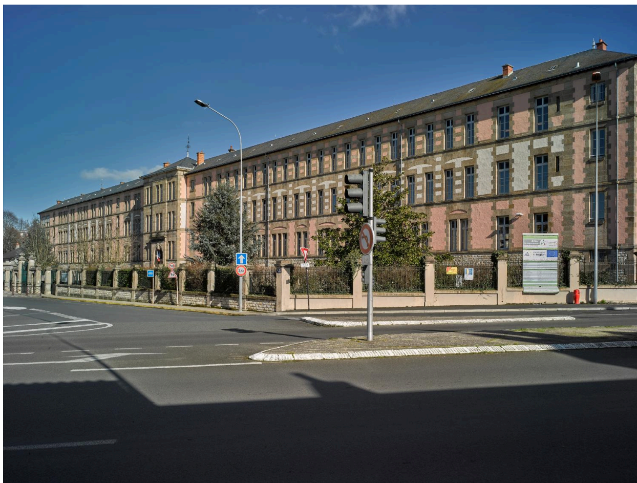
Façade sur la rue du 8-Mai. Orientée à l'est.
