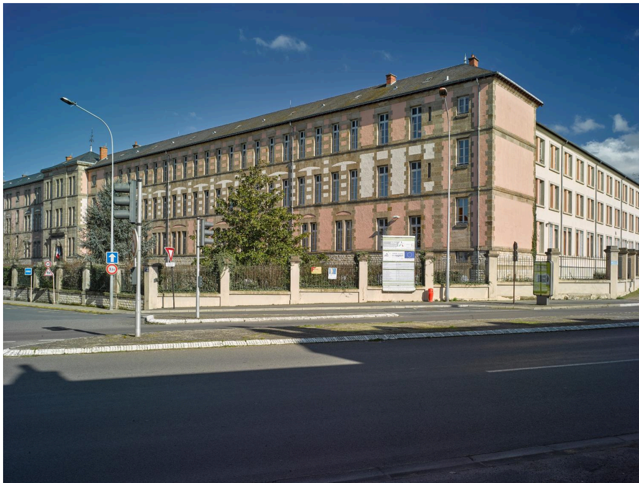
Angle de la rue du 8-Mai et de l'avenue Alsace-Lorraine. Sur la gauche, filant, le corps de bâtiment ajouté en 1954-1956, fermant la cour au sud.
