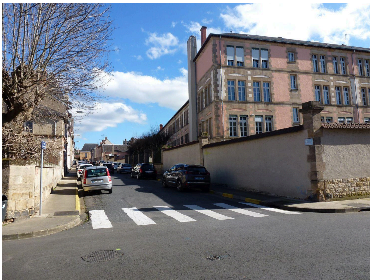
Rue Antoine-Dauvergne : élévation nord du lycée.
