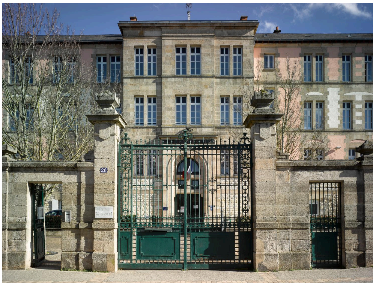
Porte d'entrée dite flamande (sans couverture) et avant-corps central de la façade.
