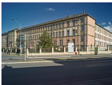
Angle de la rue du 8-Mai et de l'avenue Alsace-Lorraine. Sur la gauche, filant, le corps de bâtiment ajouté en 1954-1956, fermant la cour au sud.
