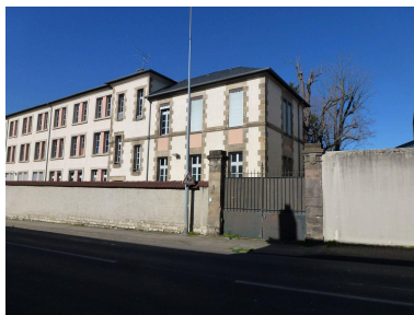
Avenue d'Alsace-Lorraine : porte d'entrée secondaire du lycée, deux corps de bâtiments de la campagne principale de travaux (l'emplacement décalé des baies indique qu'il s'agit pour l'un d'éclairage d'une cage d'escalier, située à l'extrémité du bâtiment ouest). A gauche du cliché, aile construite en 1954-1956 qui ferme la cour au sud. Phot. Bénédicte Renaud-Morand IVR84_20220300007NUCA
