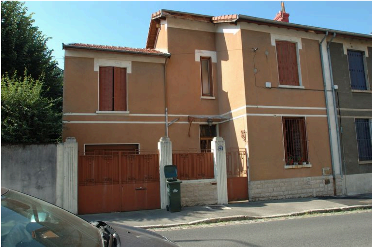
Vue du n°28.
