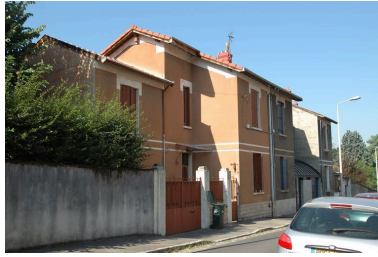
Vue générale. Phot. Catherine Guillot IVR82_20126902757NUCA
