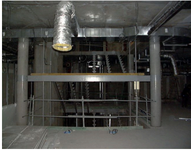
L'escalier en cours de construction, 23 mars 2000 Phot. Véronique Belle IVR82_20006900448NUCA
