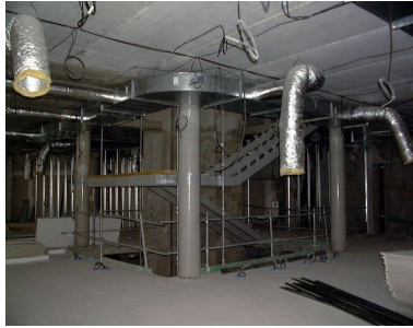
L'escalier en cours de construction, 23 mars 2000 Phot. Véronique Belle IVR82_20006900449NUCA
