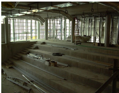
L'auditorium en cours de construction, 23 mars 2000 Phot. Véronique Belle IVR82_20006900452NUCA
