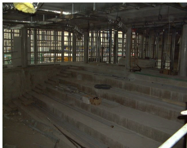
L'auditorium en cours de construction, 23 mars 2000 Phot. Véronique Belle IVR82_20006900453NUCA
