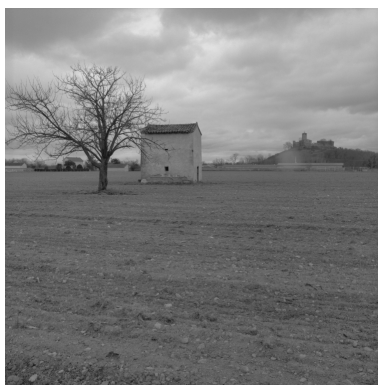
Vue d'ensemble, depuis l'ouest. Phot. Eric Dessert IVR82_20034201595X
