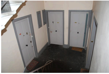
Vue intérieure : la disposition d'un palier Phot. Magali Delavenne IVR84_20186900863NUCA
