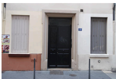
Vue rapprochée de la porte Phot. Magali Delavenne IVR84_20186900859NUCA
