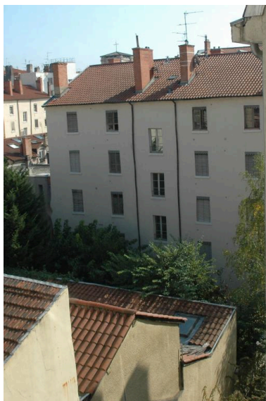
Vue partielle de l'élévation postérieure Phot. Magali Delavenne IVR84_20186900865NUCA
