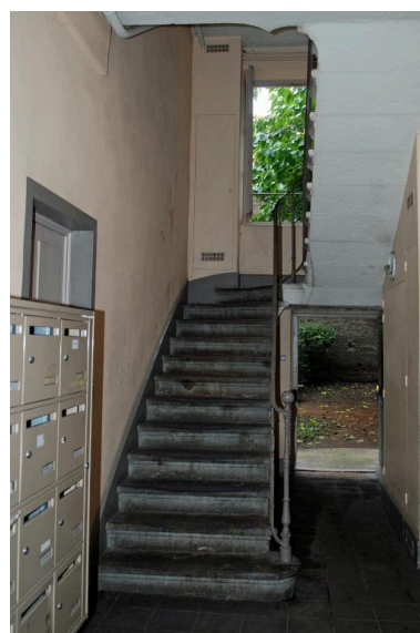
Vue intérieure : l'allée et le départ de l'escalier Phot. Magali Delavenne IVR84_20186900862NUCA
