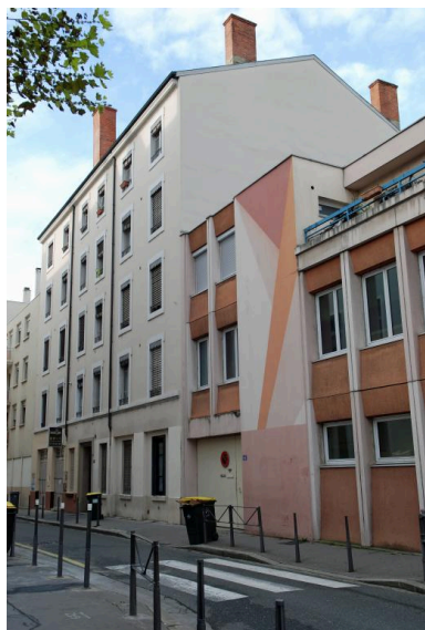
Vue d'ensemble, depuis le nord-est Phot. Magali Delavenne IVR84_20186900858NUCA
