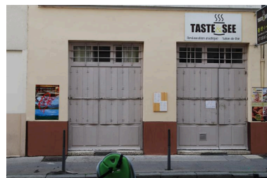
Vue rapprochée du rez-de-chaussée Phot. Magali Delavenne IVR84_20186900860NUCA
