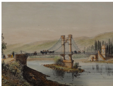
Détail Phot. Lionel Sauzade IVR84_20216300925NUCA
