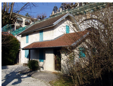
Façade ouest Phot. François Fouger IVR82_20097300493NUCA
