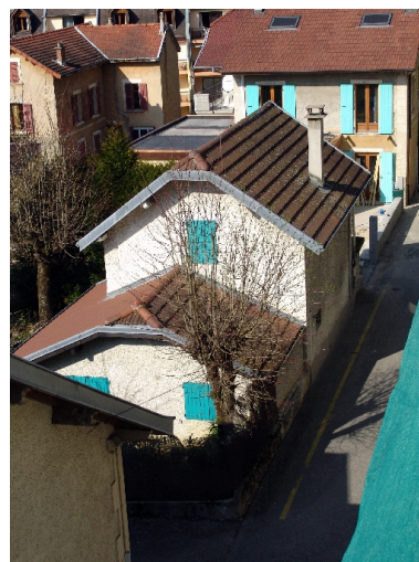
Vue des toits Phot. François Fouger IVR82_20097300492NUCA
