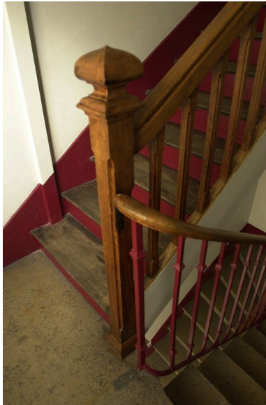
Escalier : garde-corps en fonte et garde-corps en bois Phot. Véronique Belle IVR82_20076901216NUCA
