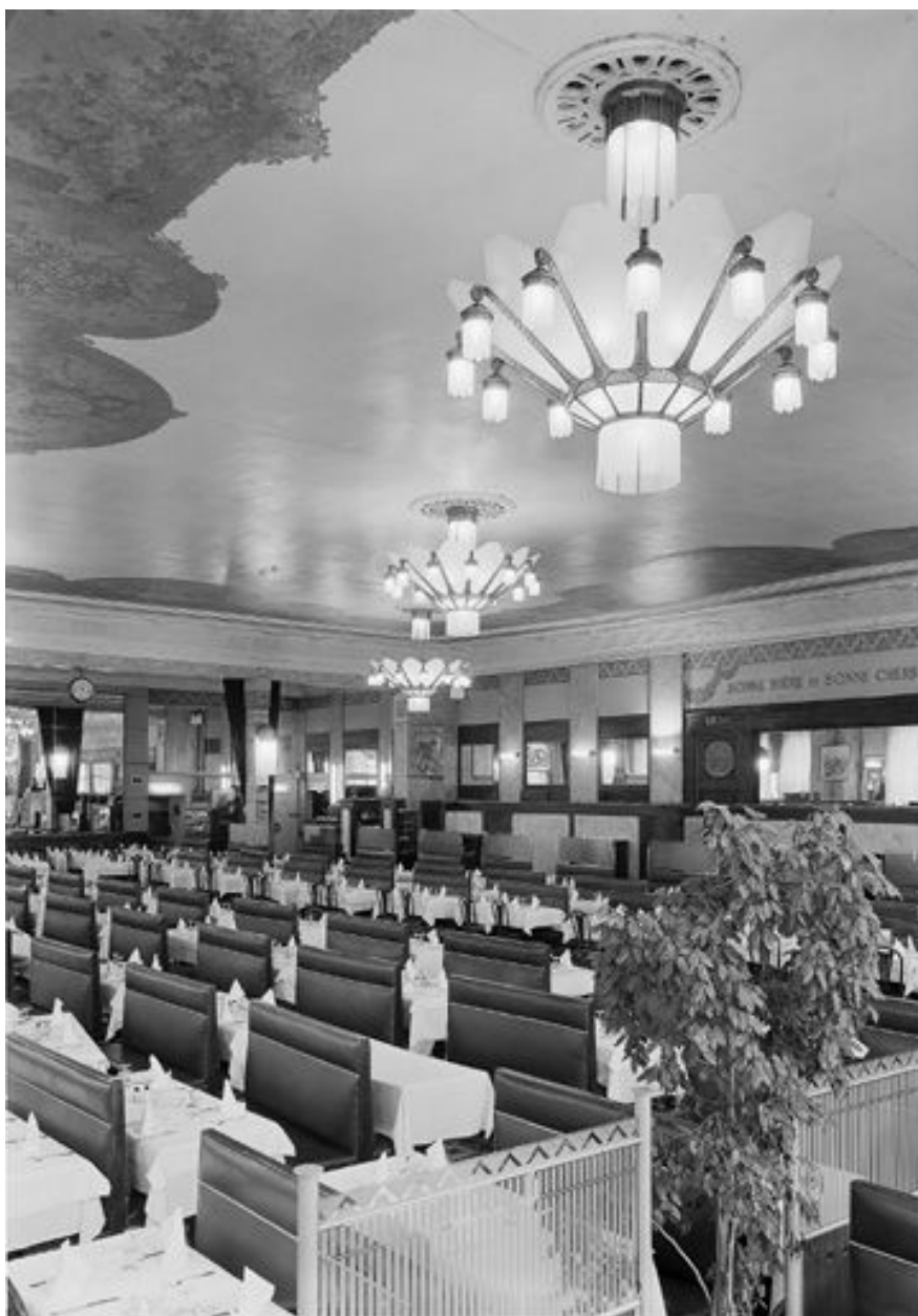
Vue intérieure générale vers le sud-ouest
