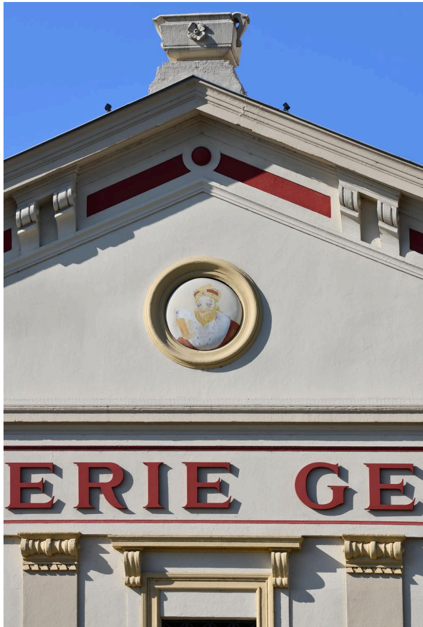
Motif central de l'élévation antérieure
