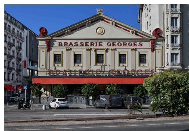
Vue de l'élévation antérieure Phot. Thierry Leroy IVR84_20226901312NUCAQ
