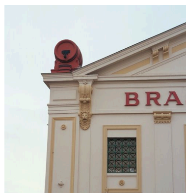
Motif latéral de l'élévation antérieure Phot. Didier Gourbin IVR82_20026903207XA
