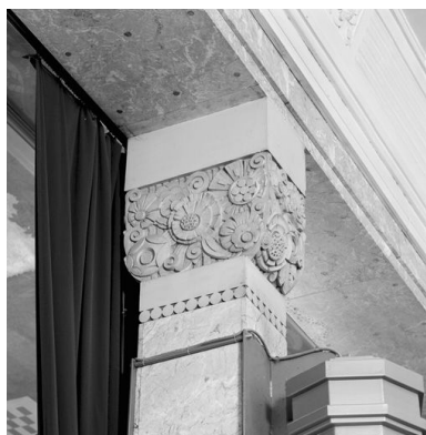
Détail d'un chapiteau ornant les piliers qui séparent la grande salle de l'ancienne salle de billard Phot. Didier Gourbin
