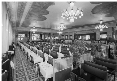
Vue intérieure générale vers le sud-ouest Phot. Jean-Marie Refflé IVR82_20026903212P
