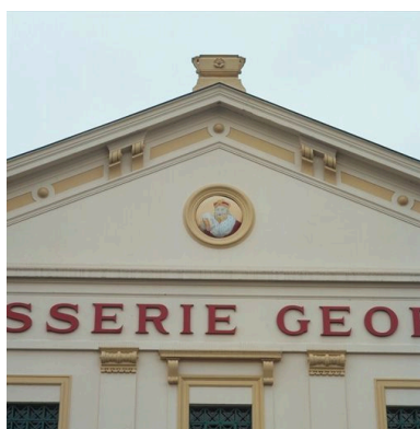
Motif central de l'élévation antérieure Phot. Didier Gourbin IVR82_20026903205XA
