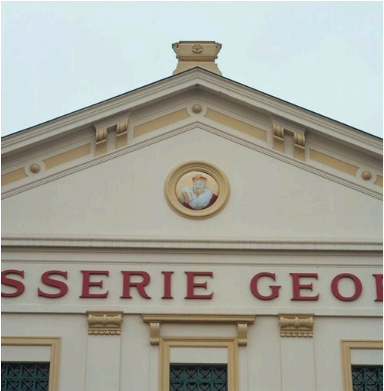
Motif central de l'élévation antérieure
