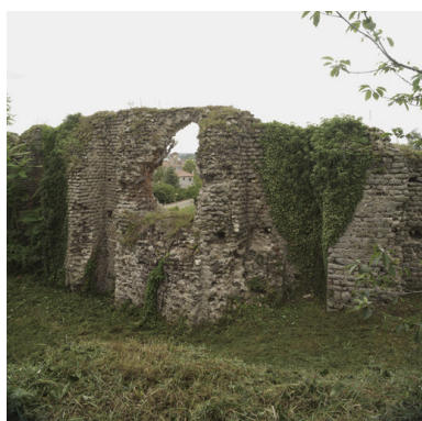
Vue générale des quelques éléments encore en élévation (au nord-ouest) du théâtre. Phot. Eric Dessert IVR82_20084200978NUCA
