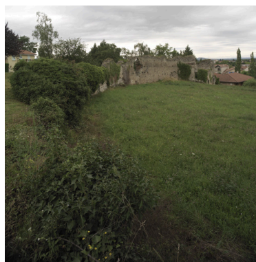
Vue générale de la partie nord-ouest du théâtre. Phot. Eric Dessert IVR82_20084200977NUCA
