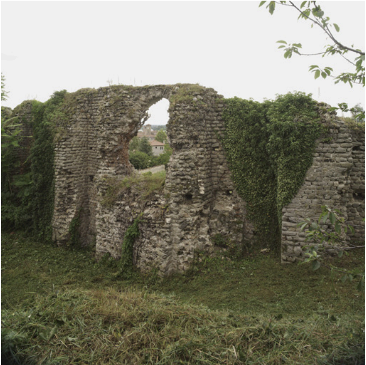
Vue générale des quelques éléments encore en élévation (au nord-ouest) du théâtre.
