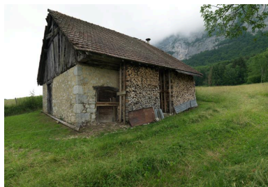
Vue d'ensemble de trois-quarts avant gauche de la ferme Phot. Thierry Leroy IVR82_20157402525NUCAQ
