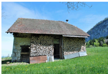
Vue d'ensemble de la façade sud. Phot. Thierry Monnet IVR84_20187400278NUCA
