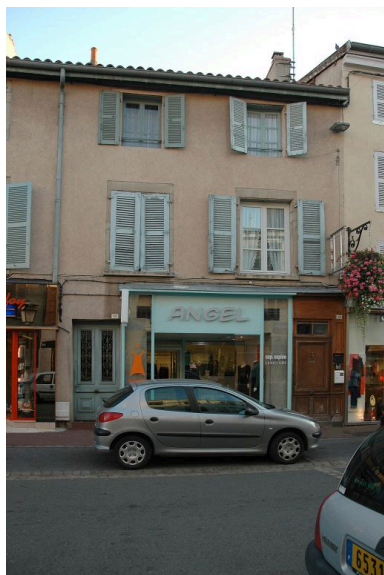
Vue générale sur la rue Tupinerie. Phot. Simone Hartmann-Nussbaum IVR82_20114200662NUCA
