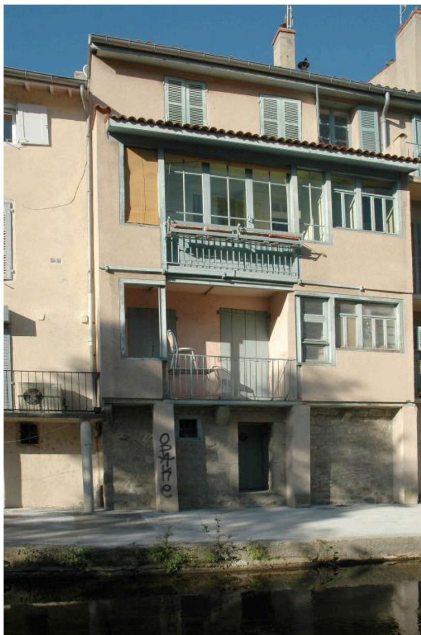
Elévation postérieure du côté de la rivière.
