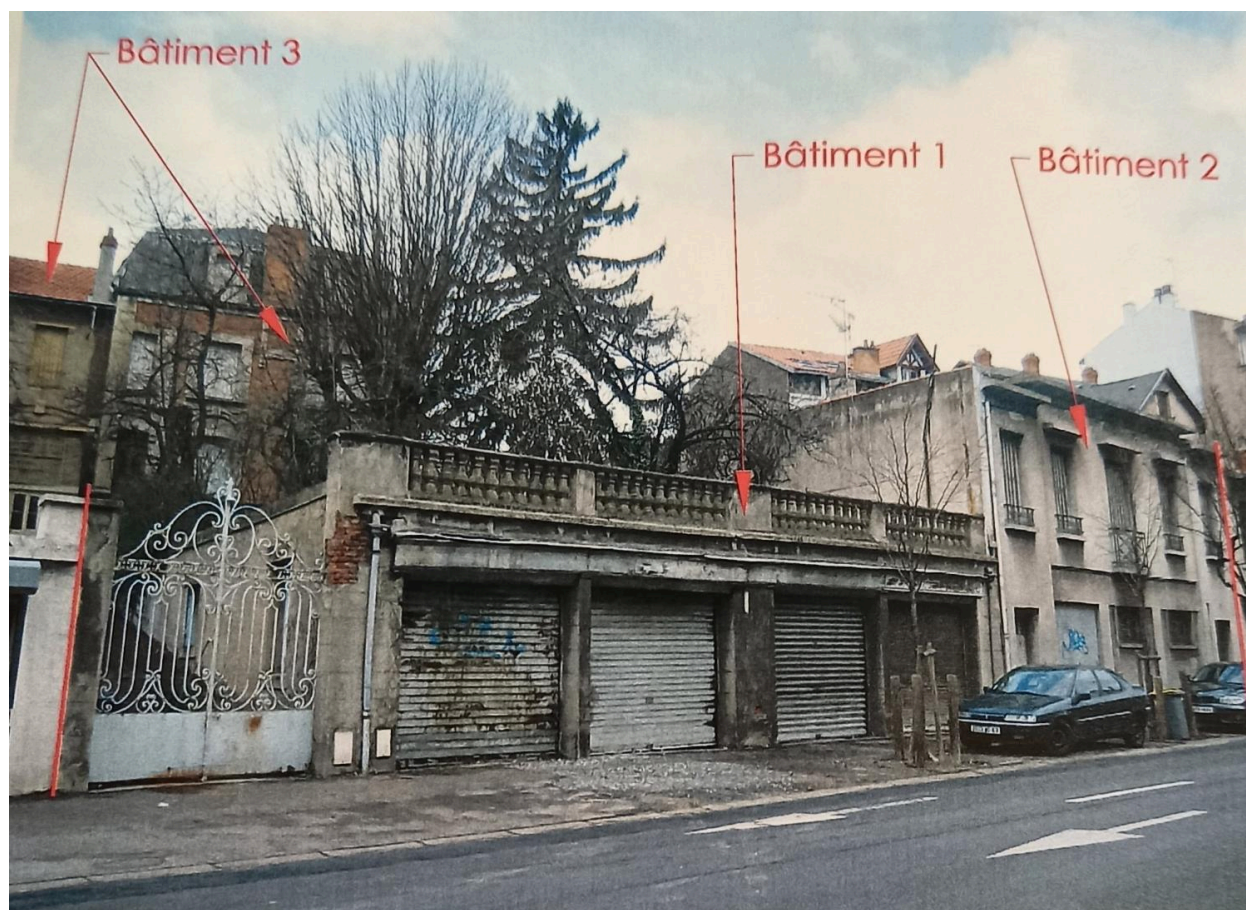
Elévation sur le boulevard Lavoisier, n°68-70 avant démolition
