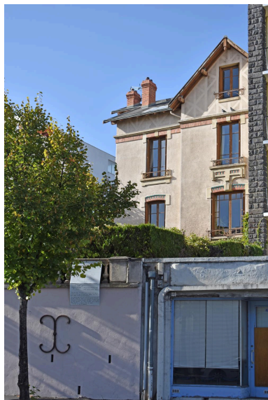
Elévation du n°64 sur le boulevard Lavoisier Phot. Félicie Fougère IVR84_20236300860NUC4A
