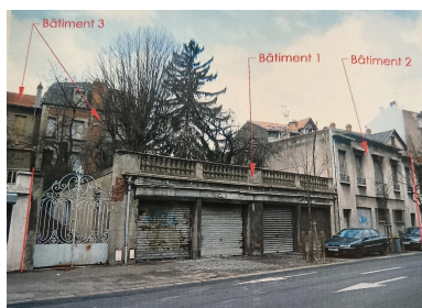
Elévation sur le boulevard Lavoisier, n°68-70 avant démolition Repro. Félicie Fougère , Autr. DHA Architecte IVR84_20236300834NUCA
