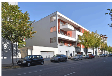
Elévation sur le boulevard Lavoisier, n°68-70 Phot. Félicie Fougère IVR84_20236300861NUC4A
