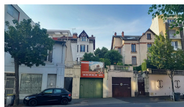
Elévations sur le boulevard Lavoisier Phot. Félicie Fougère IVR84_20236300779NUC4A
