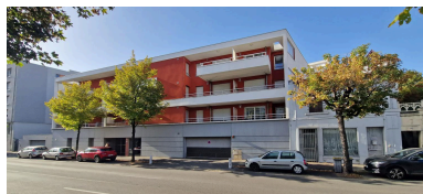
Elévation sur le boulevard Lavoisier, n°68 - 70 Phot. Félicie Fougère IVR84_20236300857NUC4A
