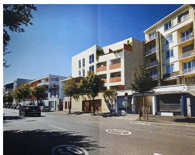
Préfiguration de l'élévation sur le boulevard n°64 et 66. Phénomène de rez-de-chaussée aveugles. Repro. Félicie Fougère , Autr. William Teissier IVR84_20236300859NUCA
