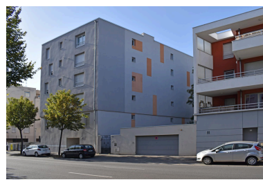
Elévation aveugle et pignon du n°74 vus depuis le boulevard Lavoisier Phot. Félicie Fougère IVR84_20236300862NUC4A
