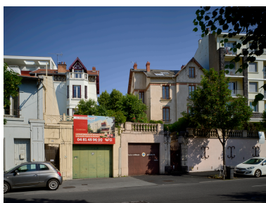
Elévations principales en retrait d'alignement Phot. Christian Parisey IVR84_20236300501NUC4A
