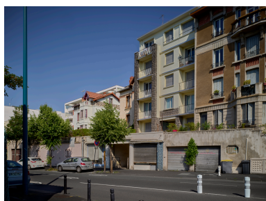
Elévation sur le boulevard Lavoisier Phot. Christian Parisey IVR84_20236300502NUC4A
