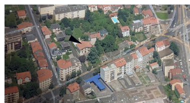
Photographie aérienne 62-76 boulevard Lavoisier, avant ou en 2007 (la flèche pointe le n°74, détruit) Repro. Félicie Fougère, Autr. DHA Architecte IVR84_20236300854NUCA
