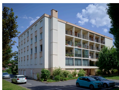
Un des deux immeubles construits dans les années 1970 à l'extrémité nord-est de la cité.
