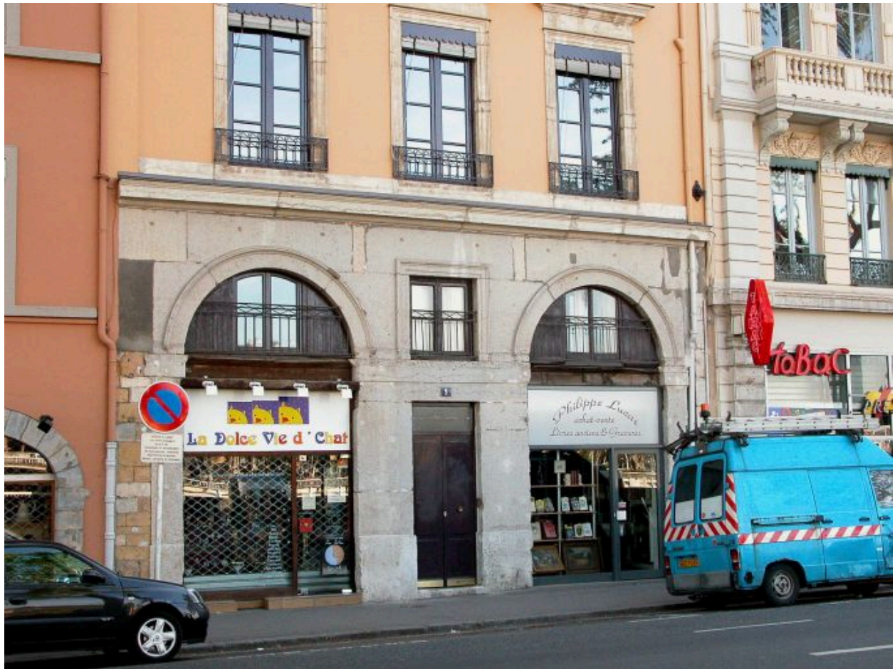
Façade, vue des deux premiers niveaux
