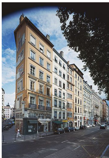
Vue générale des façades 6 à 9, quai Pêcherie Phot. Didier Gourbin IVR82_20046900837PA
