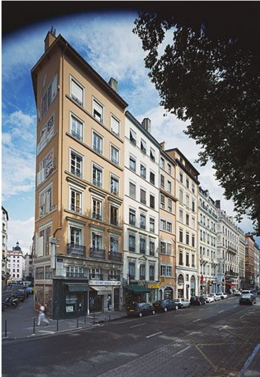
Vue générale des façades 6 à 9, quai Pêcherie
