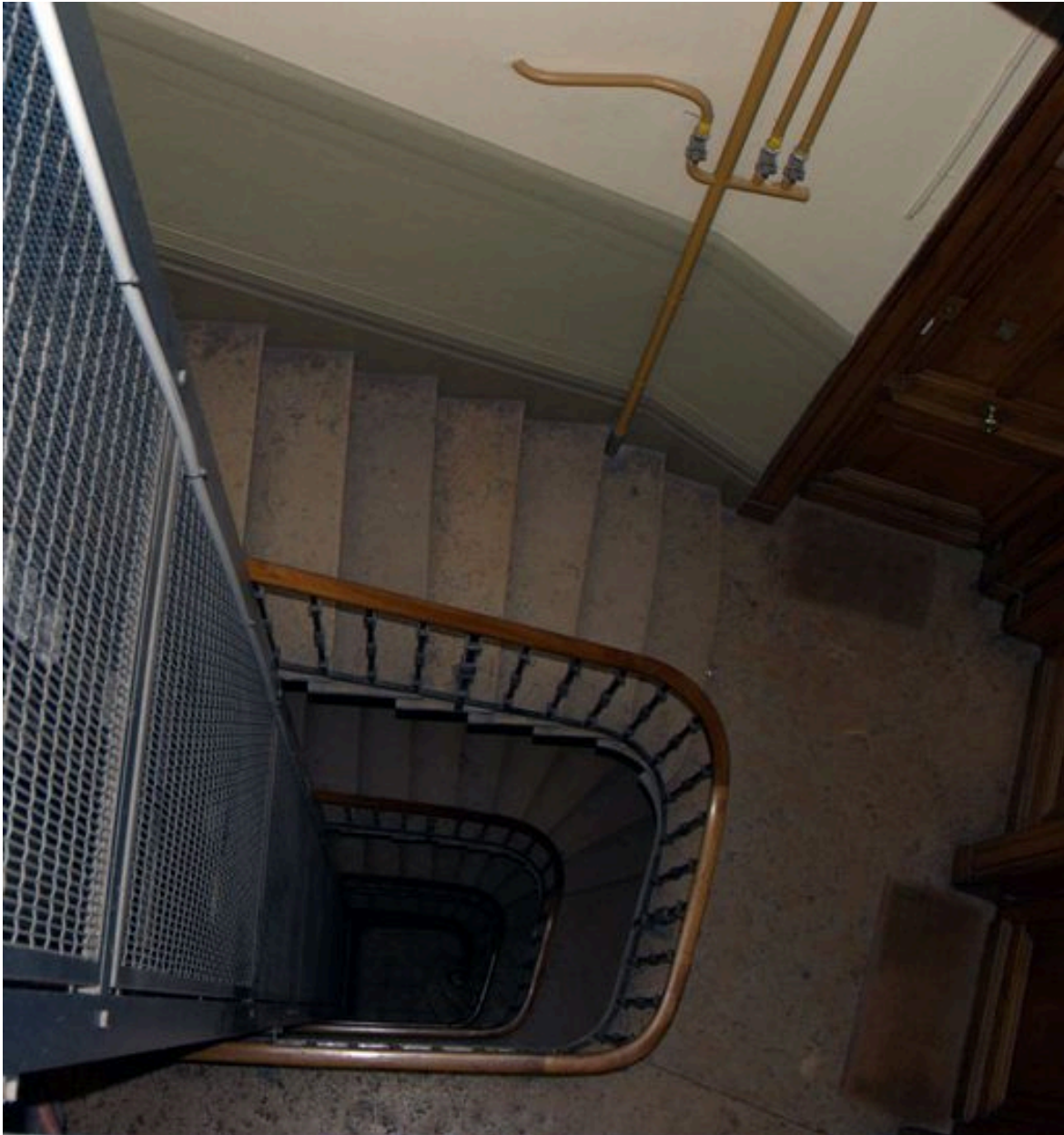
Vue de l'escalier depuis le haut
