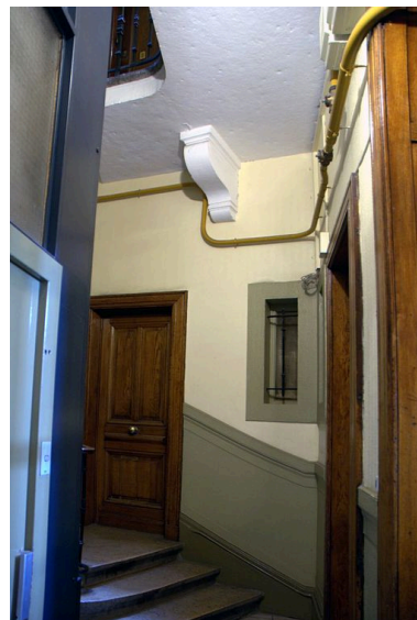
Vue de l'entrée de la loge de gardien Phot. Maryannick Chalabi IVR82_20116901512NUCA
