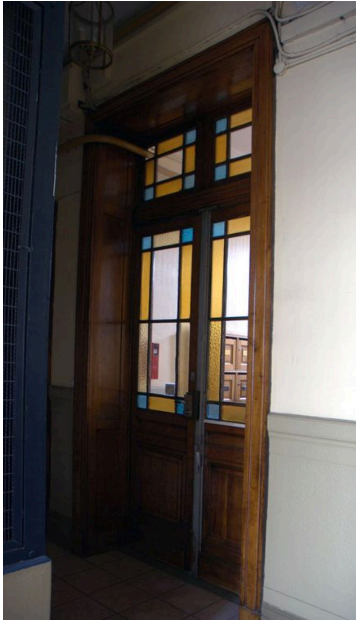
Porte du sas, depuis la cage d'escalier
