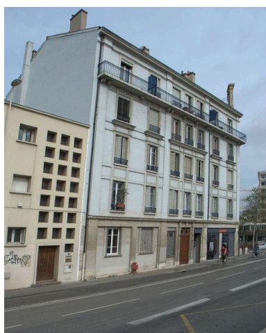
Vue générale depuis le sud-est Phot. Maryannick Chalabi IVR82_20116901508NUCA
