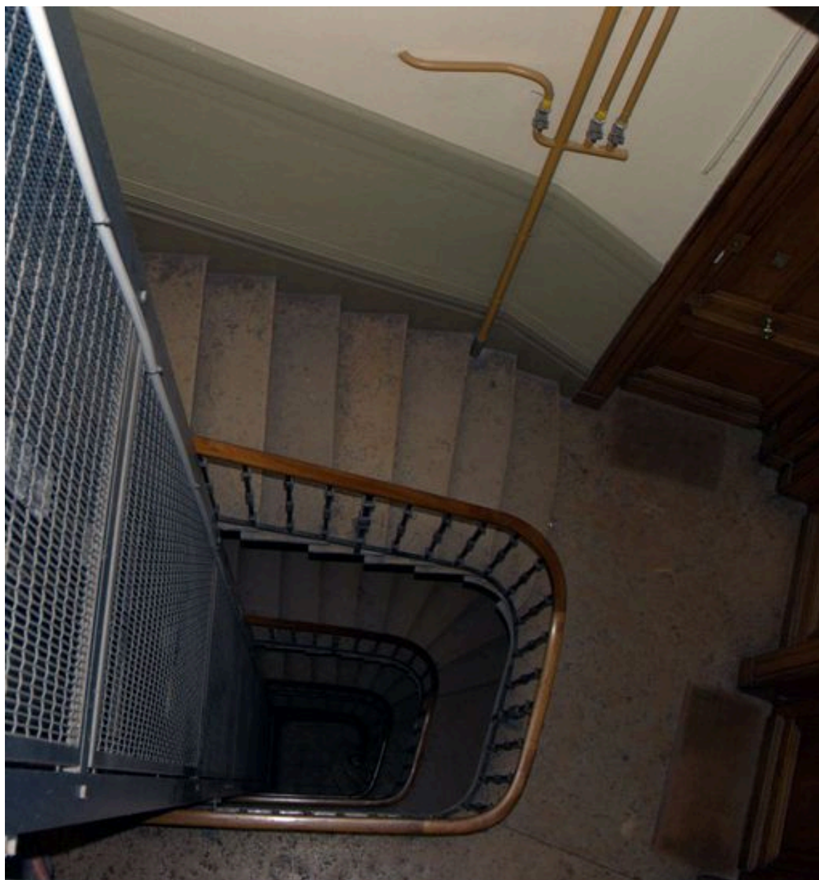
Vue de l'escalier depuis le haut
