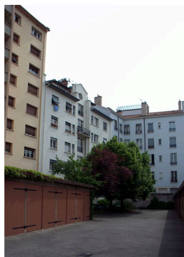
Elévation postérieure, depuis l'ouest Phot. Maryannick Chalabi IVR82_20116901520NUCA
