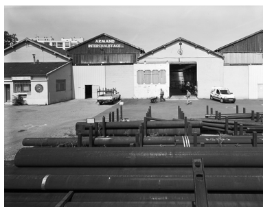
Cour intérieure, vue des ateliers Phot. Eric Dessert IVR82_20026904431V
