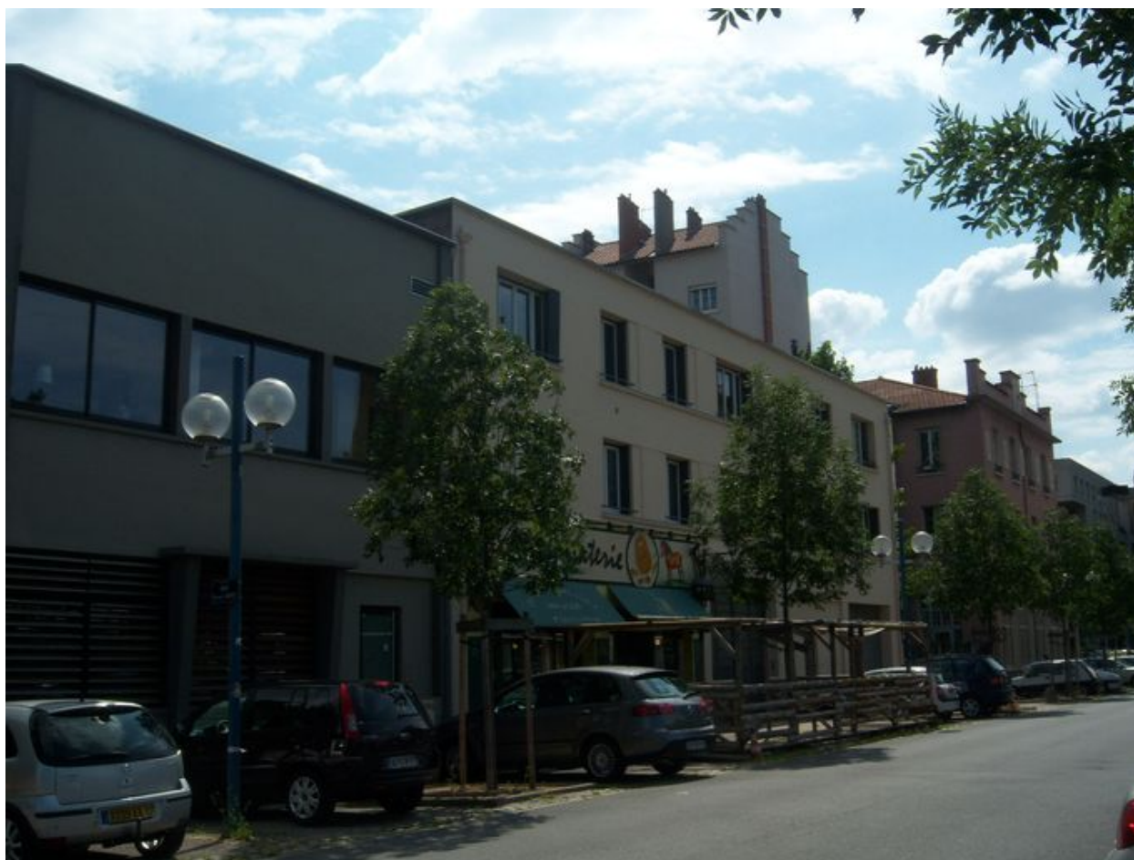
Vue d'ensemble, rue Challemel Lacour
