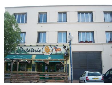
Élévation principale, aile Ouest Phot. Salohy Rakotomalala IVR82_20106901482NUCA
