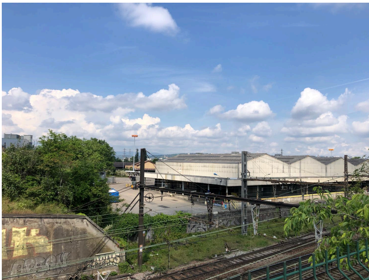
Vue ouest, usines Solvay, rue Bourrelier, Saint-Fons
