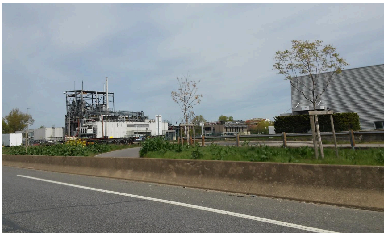
L'usine Solvay à Saint-Fons (vue depuis l'autoroute A7)
