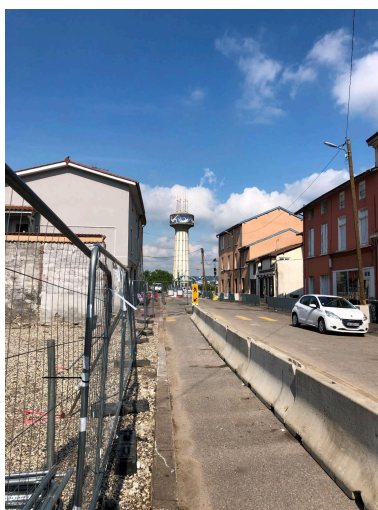
Château d'eau : vue ouest, rue Charles Plasse, Saint-Fons Phot. Léa Mauris-Demourieux IVR84_20256900731NUCA
