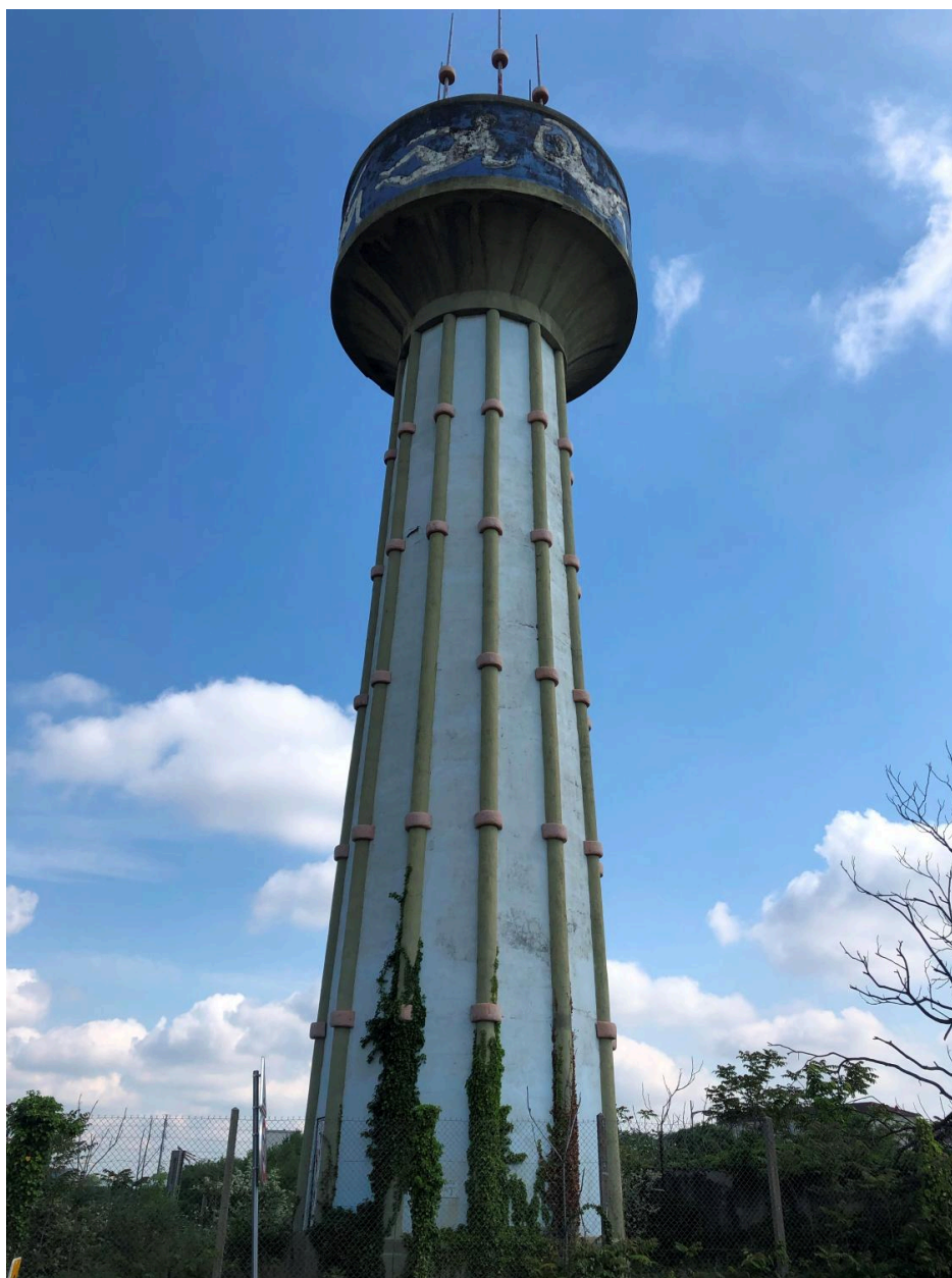
Château d'eau : vue ouest, rue Charles Plasse, Saint-Fons
