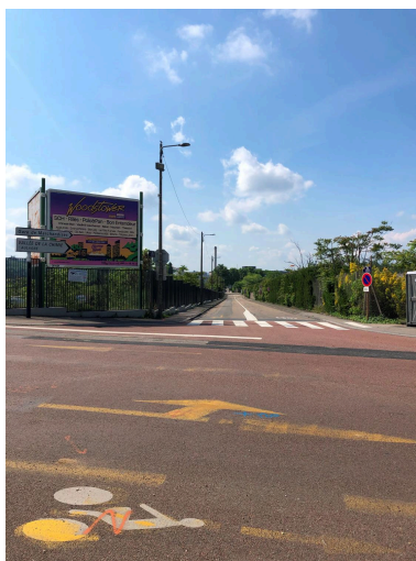
Vue sud, direction Vallée de la chimie Phot. Léa Mauris-Demourieux IVR84_20256900737NUCA
