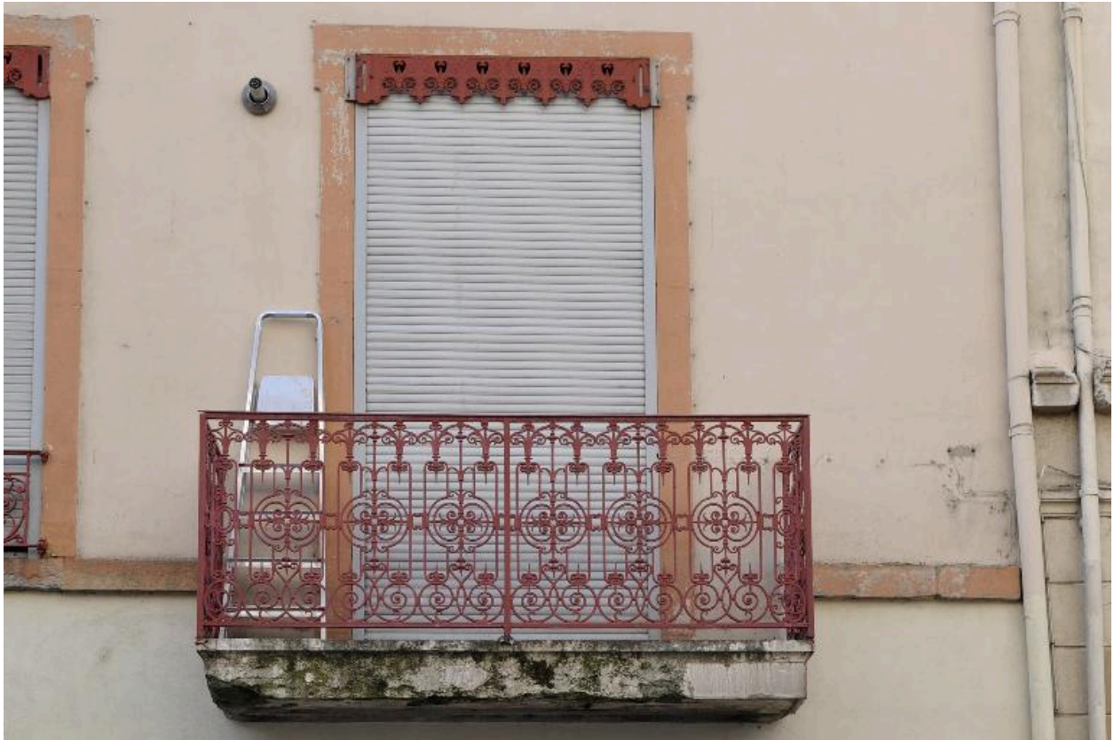
Elévation sur rue, détail du balcon
