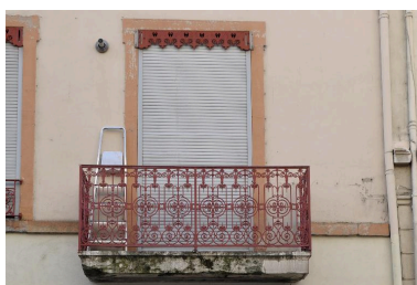
Elévation sur rue, détail du balcon Phot. Magali Delavenne IVR84_20176901019NUCA
