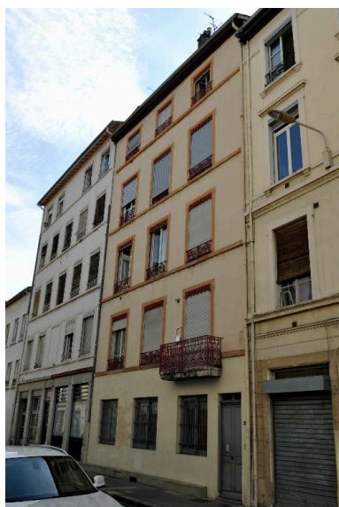
Vue générale, élévation sur rue Phot. Magali Delavenne IVR84_20176901018NUCA
