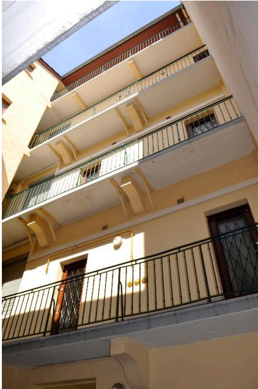
Immeuble sur rue, élévation sur cour
