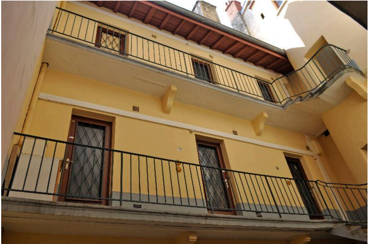
Immeuble sur cour, élévation sur cour
