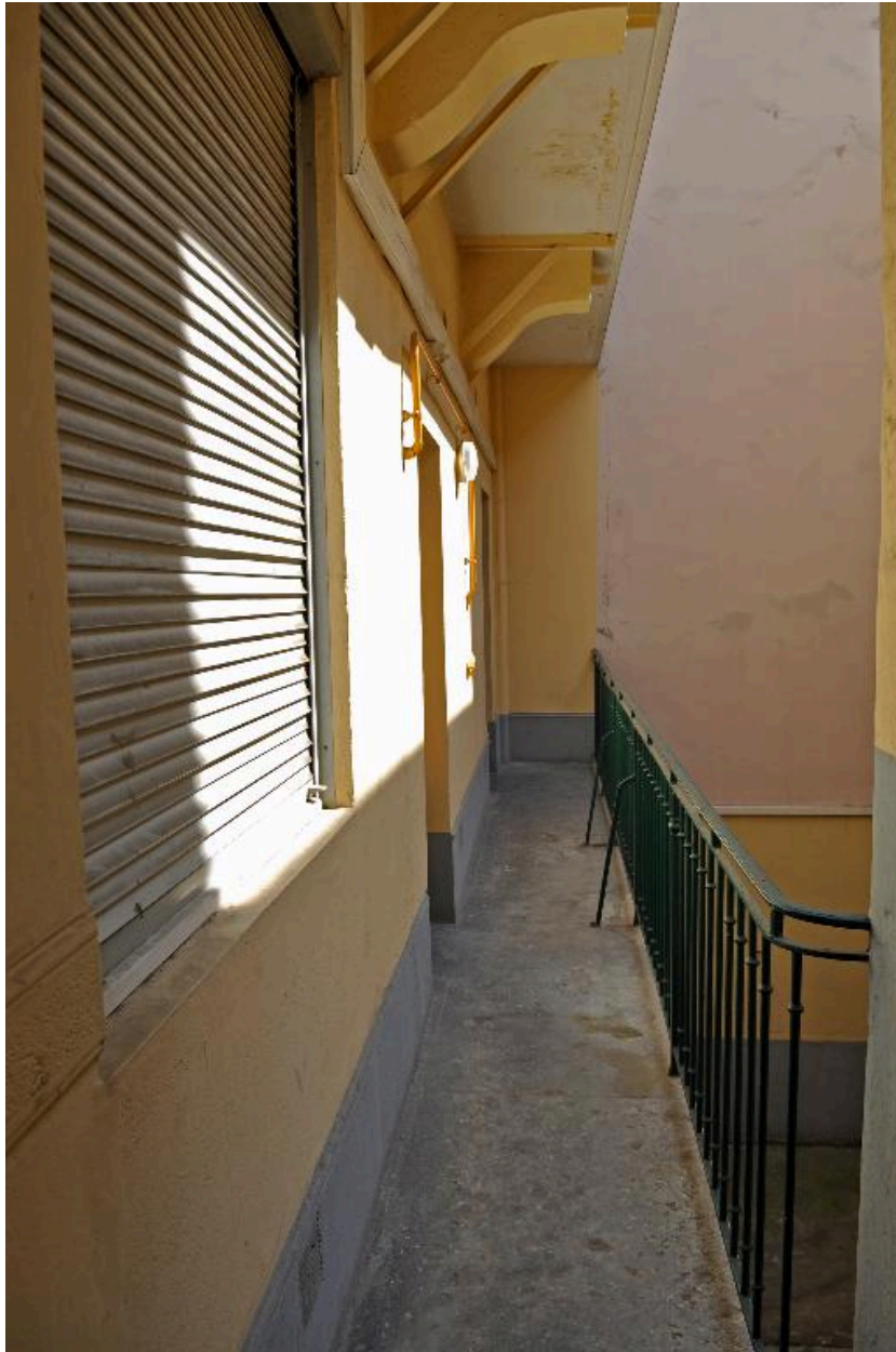
Immeuble sur rue, vue d'une coursière
