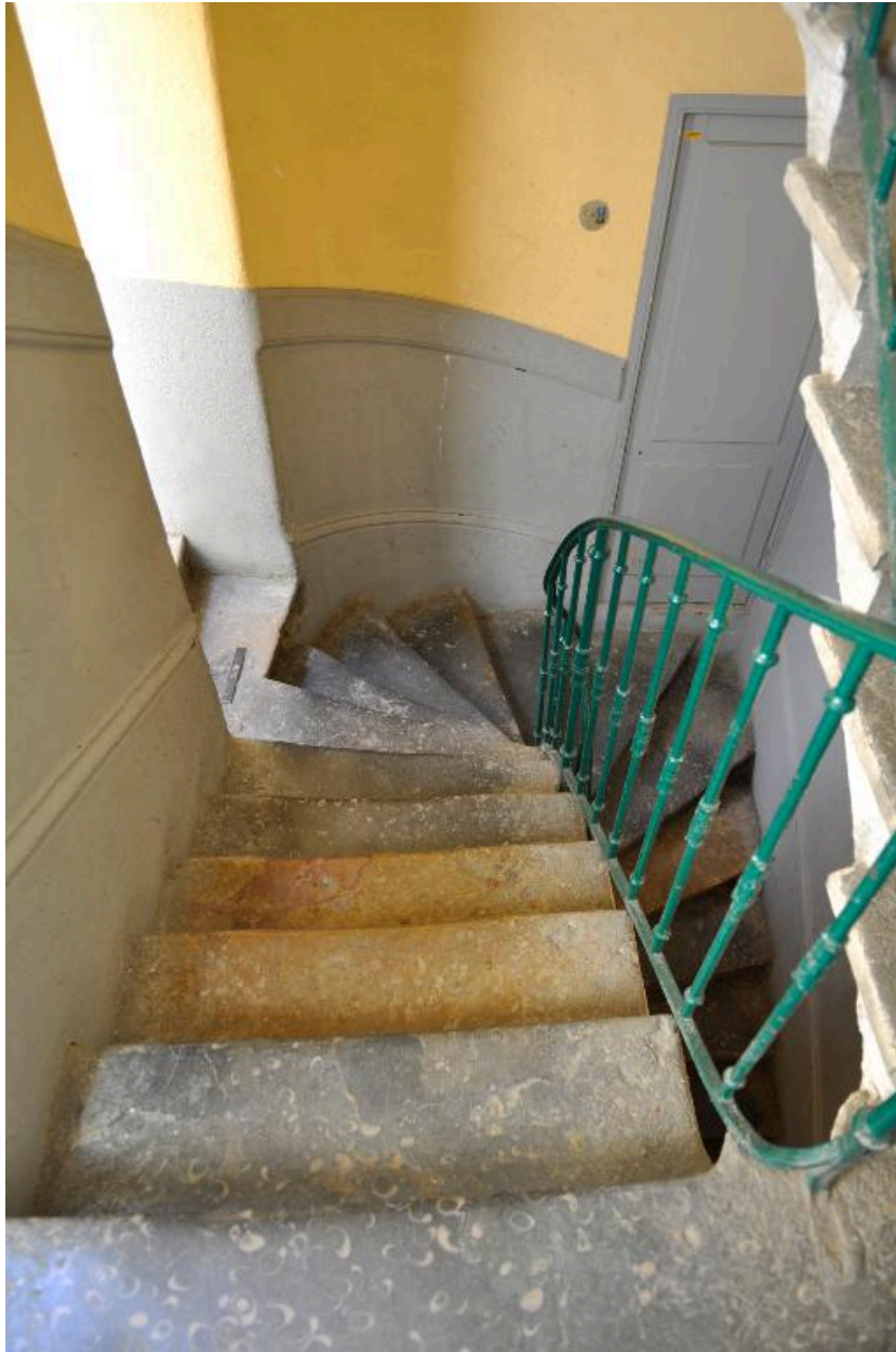
Vue de l'escalier reliant les deux corps de bâtiments
