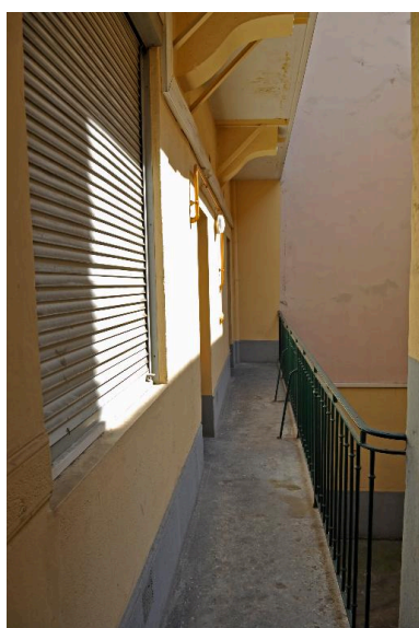
Immeuble sur rue, vue d'une coursière Phot. Magali Delavenne IVR84_20176901024NUCA
