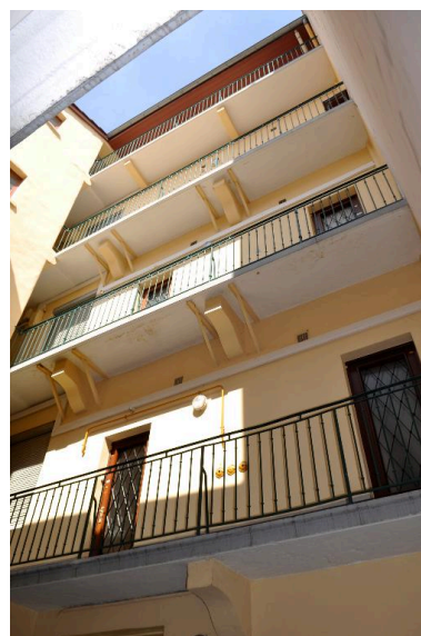
Immeuble sur rue, élévation sur cour Phot. Magali Delavenne IVR84_20176901022NUCA
