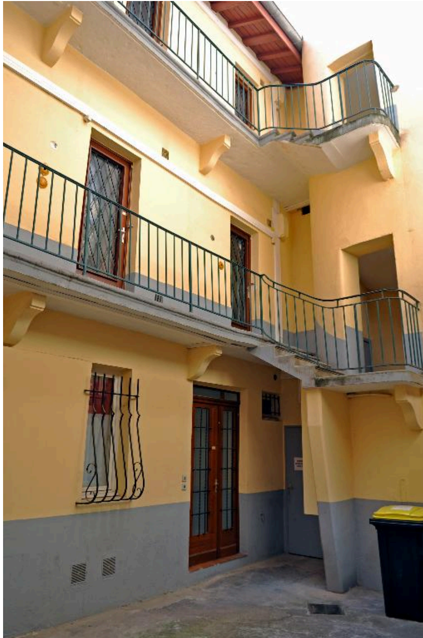
Immeuble sur cour, vue des coursières reliées à la cage d'escalier
