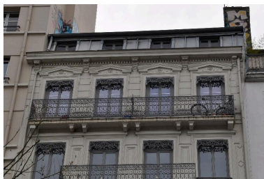
Vue du couronnement Phot. Magali Delavenne IVR84_20166900628NUCA
