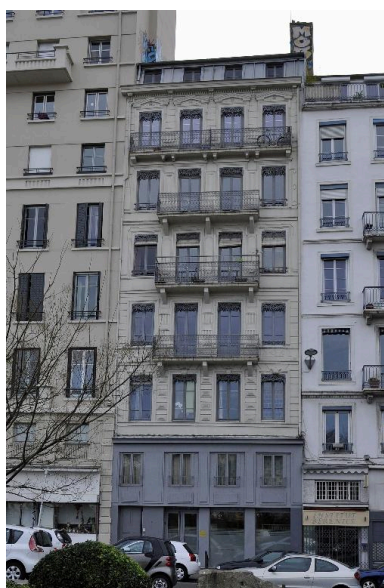
Elévation sur rue, vue générale Phot. Magali Delavenne IVR84_20166900625NUCA
