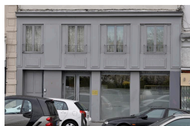
Vue du soubassement : rez-de-chaussée et entresol Phot. Magali Delavenne IVR84_20166900626NUCA
