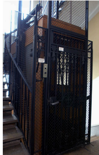
Ascenseur Phot. Maryannick Chalabi IVR82_20116901641NUCA
