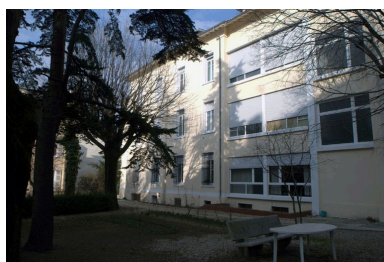
Elévation latérale sud, depuis le sud-est Phot. Maryannick Chalabi IVR82_20106905033NUCA
