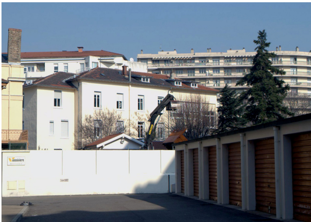
Elévation latérale sud, vue depuis le sud-ouest
