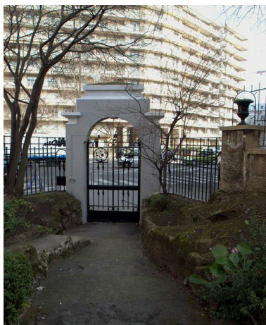
Porte principale, vue depuis le jardin Phot. Maryannick Chalabi IVR82_20106905037NUCA
