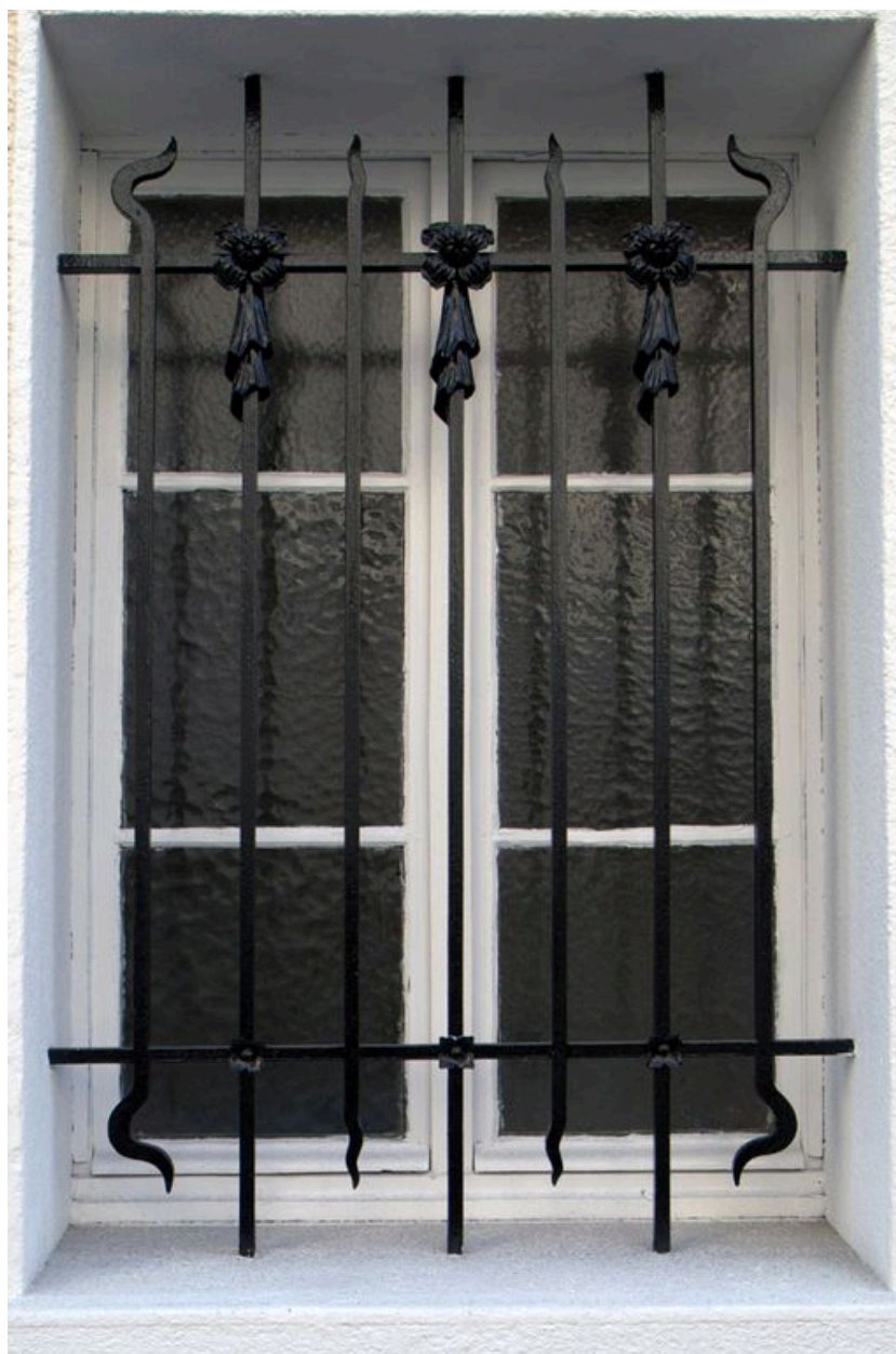
Elévation latérale nord, détail d'une grille de protection, fenêtre du rez-de-chaussée
