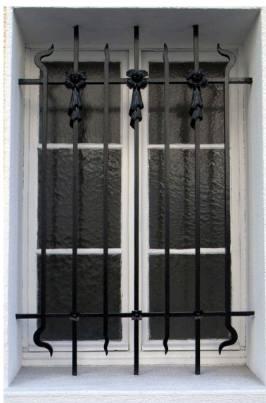
Elévation latérale nord, détail d'une grille de protection, fenêtre du rez-de-chaussée Phot. Maryannick Chalabi IVR82_20106905031NUCA
