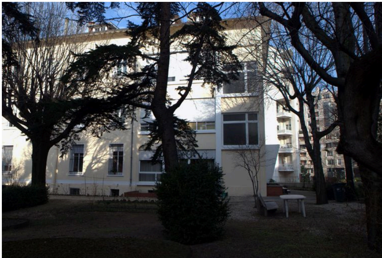
Elévation latérale sud, depuis le sud
