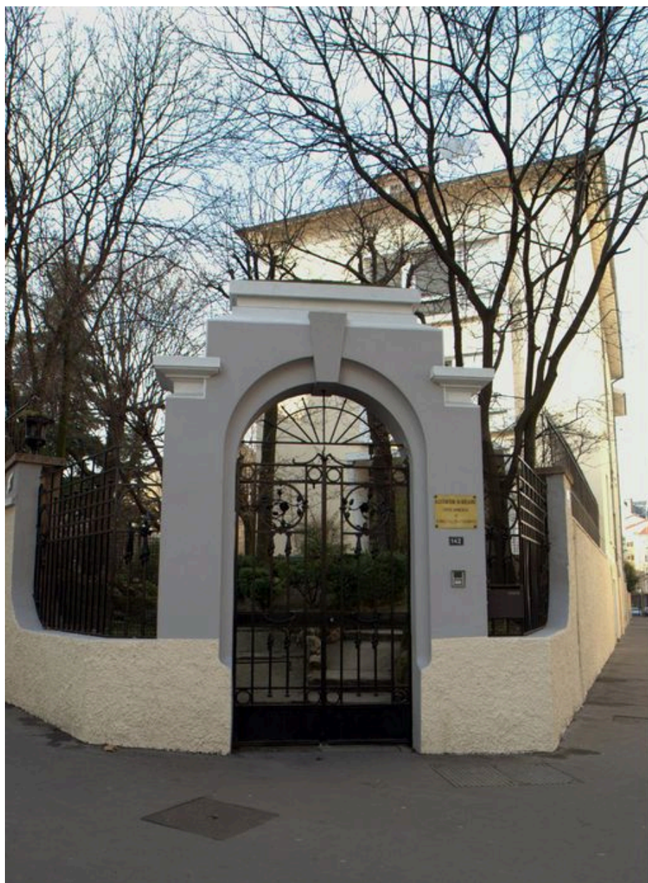
Porte principale, vue depuis la rue
