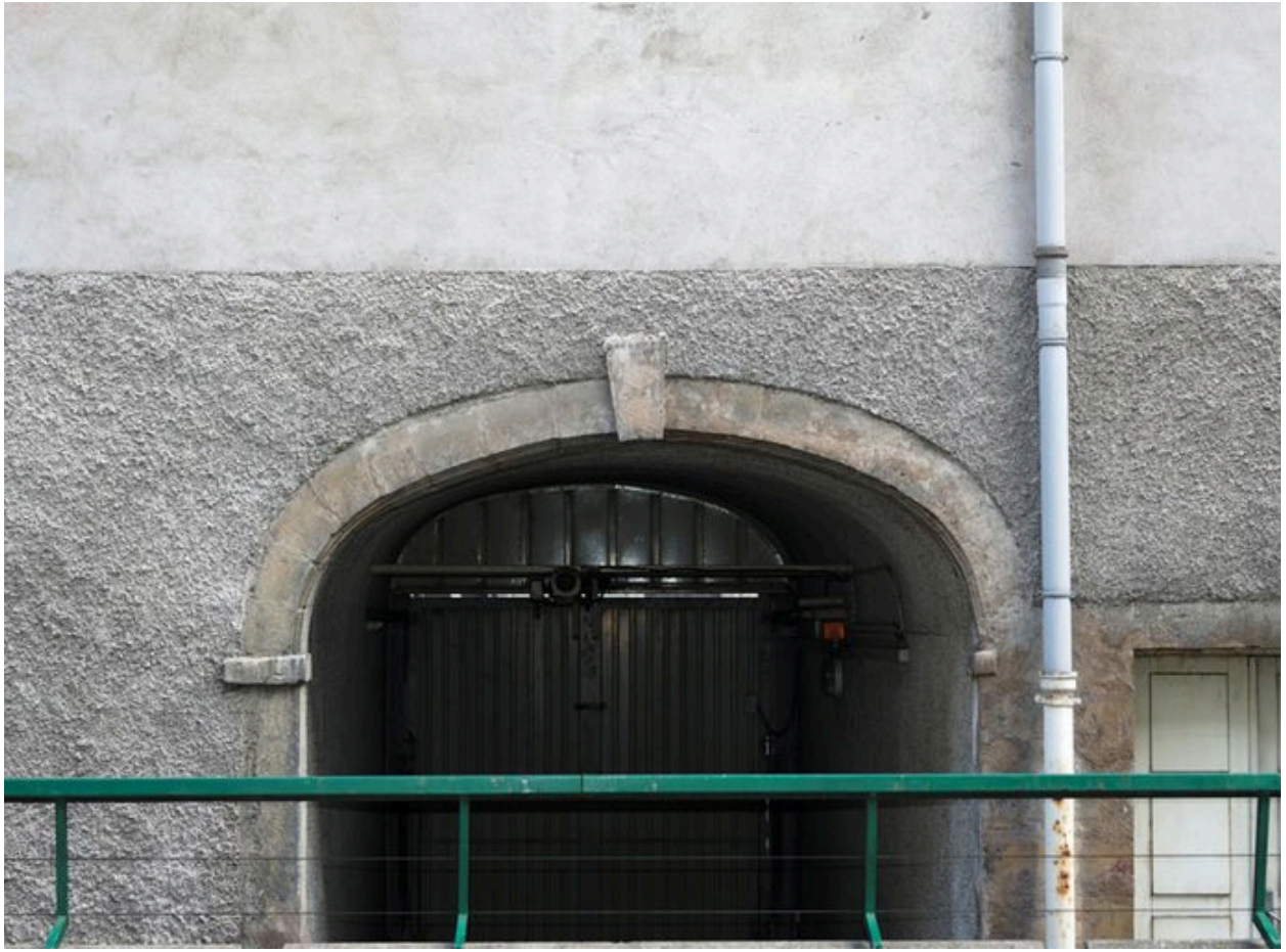
Elévation postérieure, vue partielle du passage cocher
