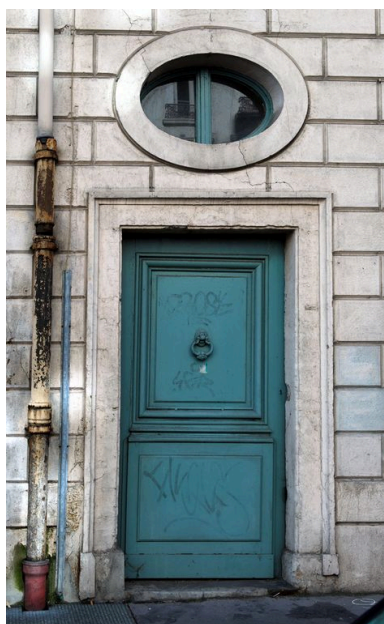
Porte piétonne Phot. Catherine Guégan IVR82_20096900733NUCA
