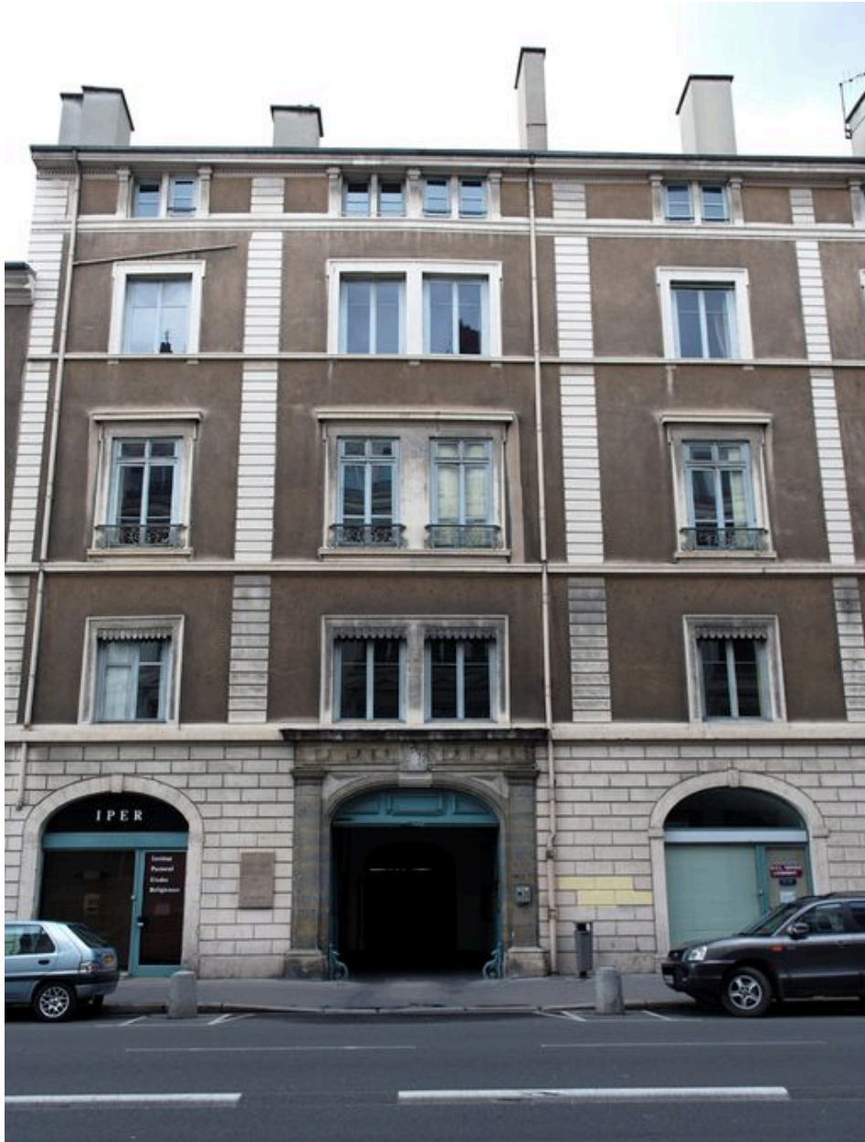
Elévation antérieure, partie orientale
