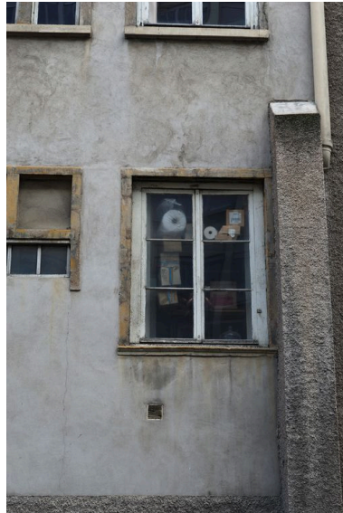
Elévation postérieure, détail d'une fenêtre Phot. Catherine Guégan IVR82_20096900708NUCA
