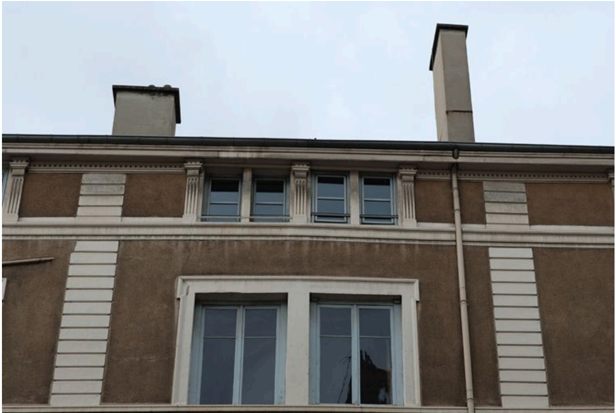
Étage en surcroît
