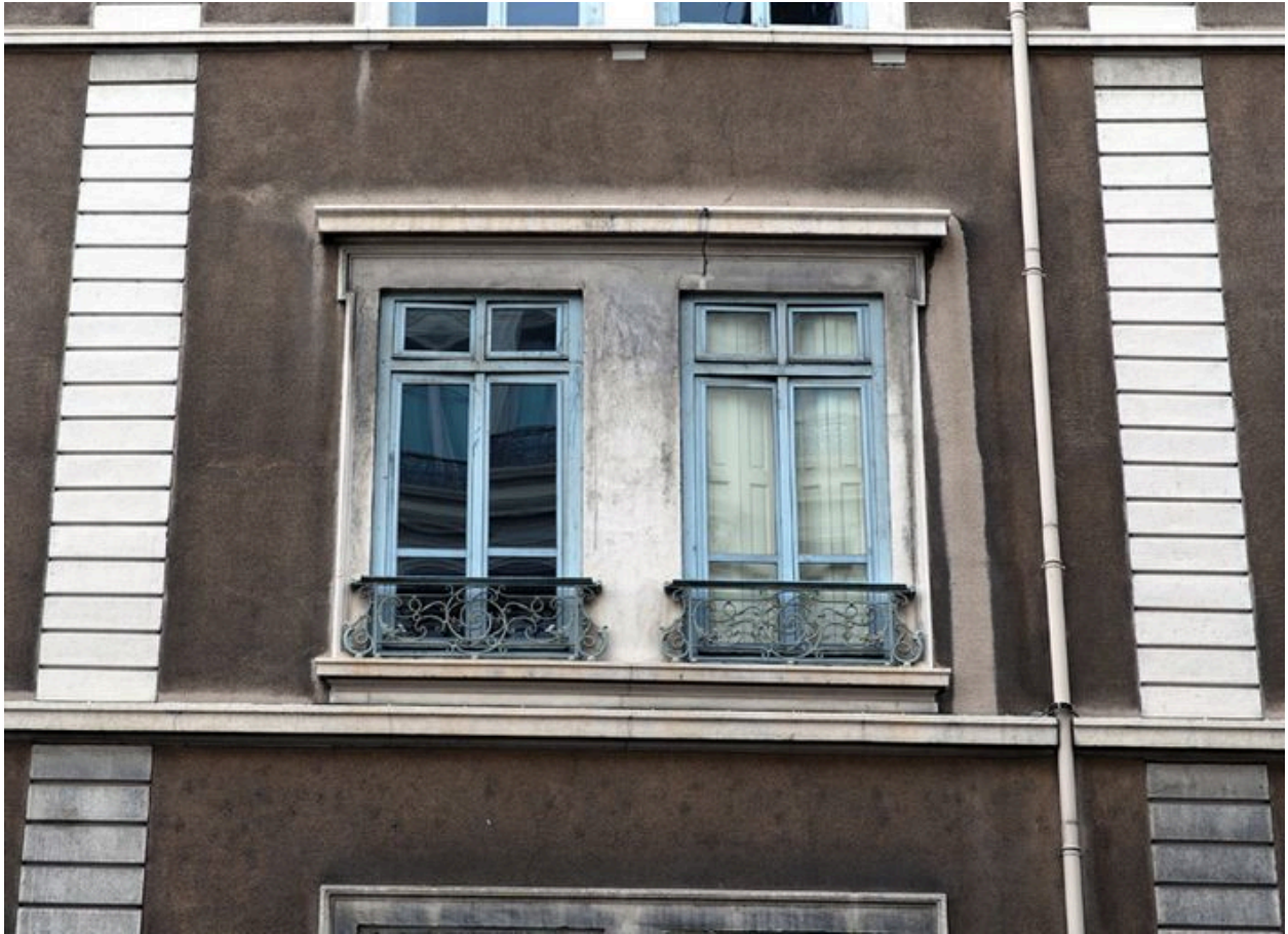
Baies du 1er étage
