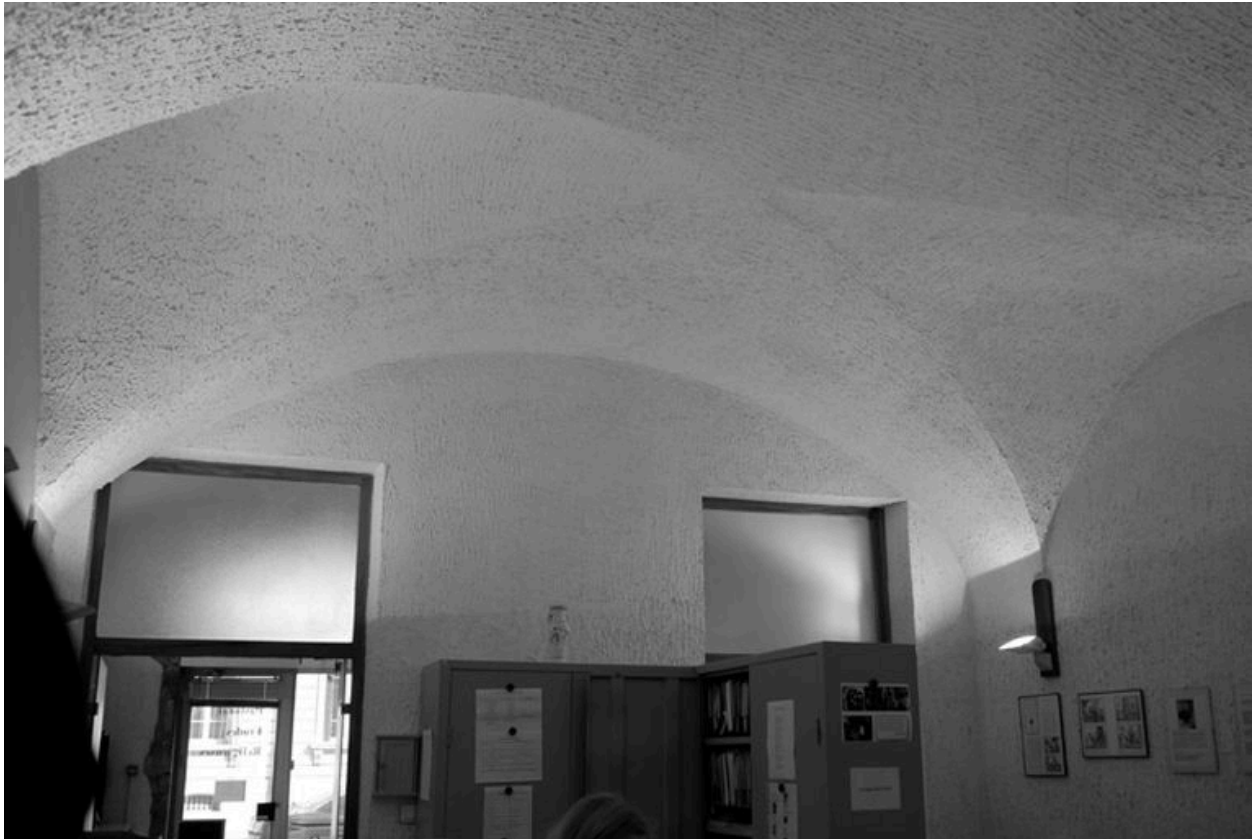
Rez-de-chaussée, ancienne boutique sur cour, actuellement bureau, voûte en croisée d'arêtes.
