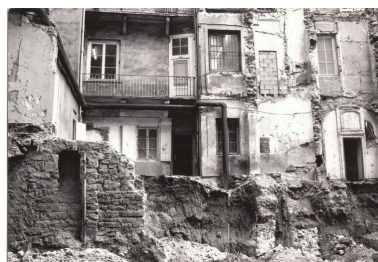
Élévation postérieure lors des travaux du bâtiment ISARA (2nd phase), photographie ancienne, 1972 Repro. Julien Defillon IVR82_20096903443NUC
