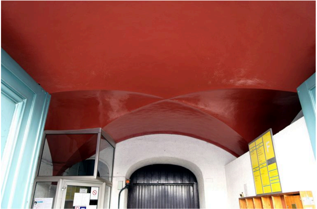
Passage cocher, détail de la voûte d'arêtes
