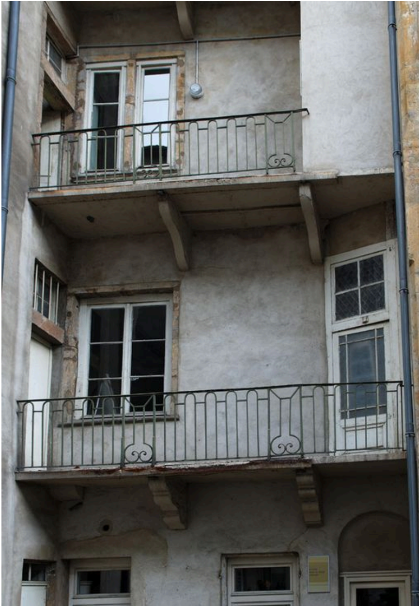
Elévation postérieure, détail des balcons
