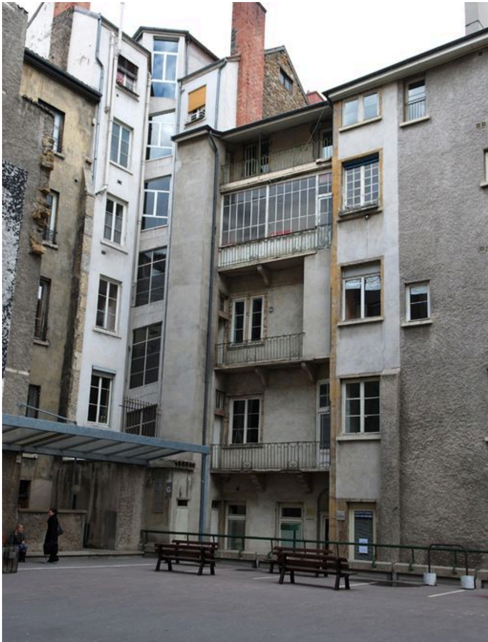
Elévation postérieure, vue de la partie occidentale
