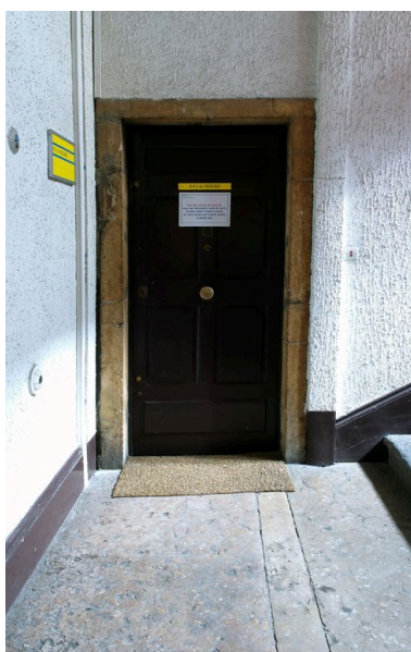
2e palier de l'escalier, porte Phot. Catherine Guégan IVR82_20096900890NUCA
