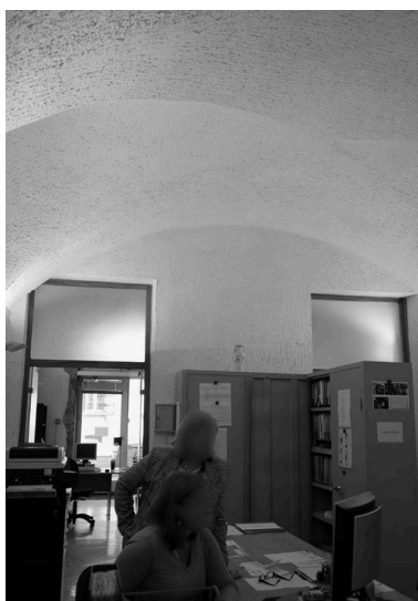
Rez-de-chaussée, ancienne boutique sur cour, actuellement bureau Phot. Catherine Guégan
