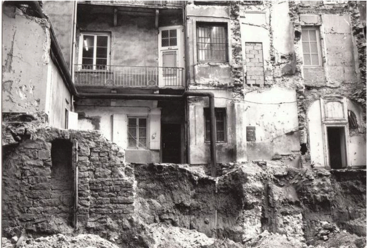
Elévation postérieure lors des travaux du bâtiment ISARA (2nd phase), photographie ancienne, 1972
