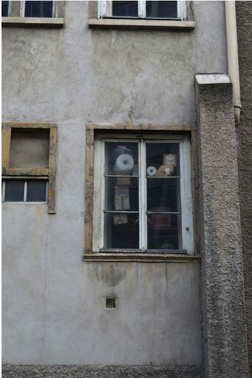
Elévation postérieure, détail d'une fenêtre
