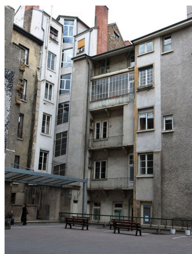
Elévation postérieure, vue de la partie occidentale Phot. Catherine Guégan IVR82_20096900709NUCA
