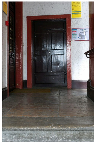
1er palier de l'escalier, porte, 17e siècle Phot. Catherine Guégan IVR82_20096900888NUCA
