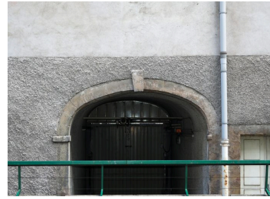
Elévation postérieure, vue partielle du passage cocher Phot. Catherine Guégan IVR82_20096900710NUCA
