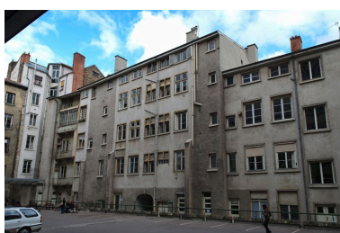
Elévation postérieure, depuis le sud-est Phot. Catherine Guégan IVR82_20096900707NUCA
