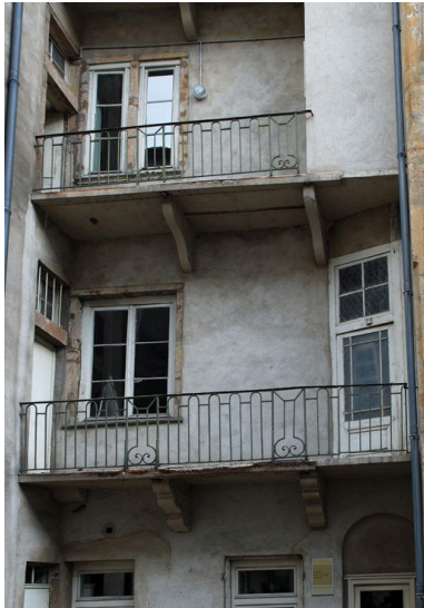
Elévation postérieure, détail des balcons Phot. Catherine Guégan IVR82_20096900711NUCA
