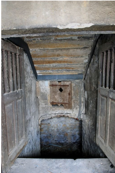
Porte d'accès aux caves, depuis la Belle Cour Phot. Catherine Guégan IVR82_20096900945NUCA
