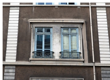
Baies du 1er étage Phot. Catherine Guégan IVR82_20096900728NUCA
