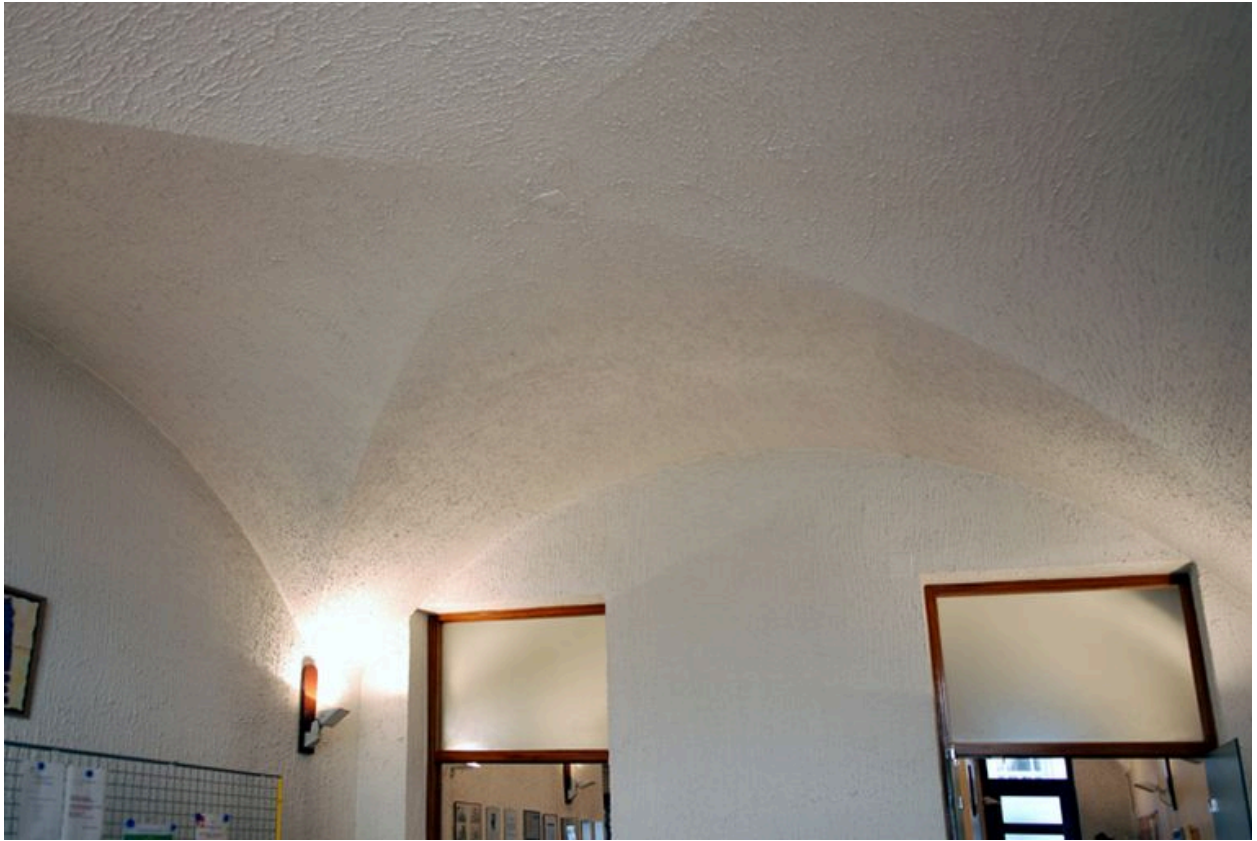
Rez-de-chaussée, ancienne boutique sur rue, actuellement bureau, voûte en croisée d'arrêtes
