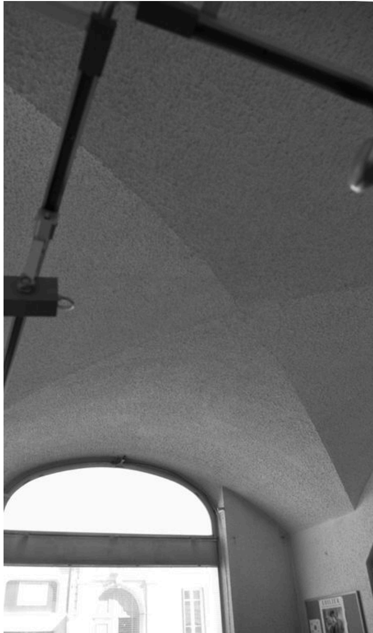
Rez-de-chaussée, ancienne boutique sur rue, actuellement bureau, détail de la voûte.
