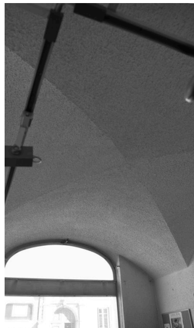
Rez-de-chaussée, ancienne boutique sur rue, actuellement bureau, détail de la voûte. Phot. Catherine Guégan IVR82_20096900746NUC
