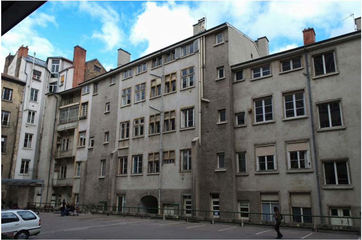
Elévation postérieure, depuis le sud-est
