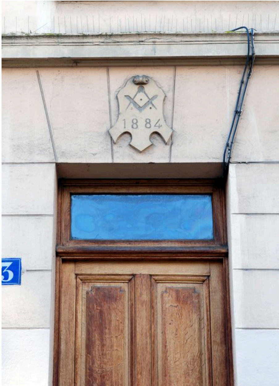
Elévation antérieure, détail de l'écusson au-dessus de la porte
