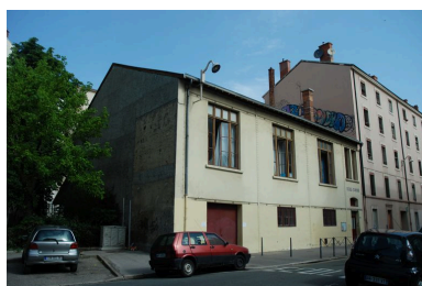
Vue d'ensemble, prise du sud-est Phot. Catherine Guillot IVR82_20126901016NUCA
