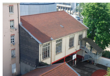
Élévation postérieure en surplomb au-dessus du préau, pignon en béton ou mâchefer Phot. Catherine Guillot IVR82_20126901019NUCA
