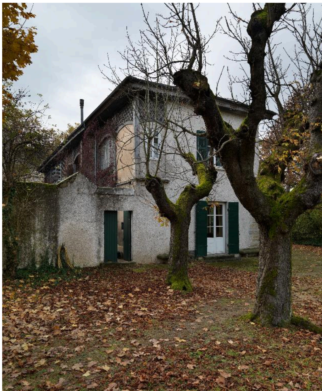
Maison de maître, depuis le nord-est
