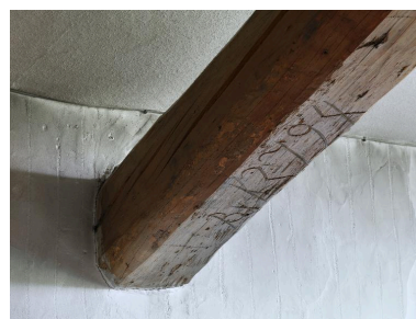
Ancienne grange, détail d'une poutre portant l'inscription 1794 (?) Phot. Thierry Leroy IVR84_20176902065NUCAQ
