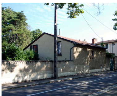
Ancienne grange, depuis le sud-ouest Phot. Catherine Guégan IVR84_20166901689NUCA
