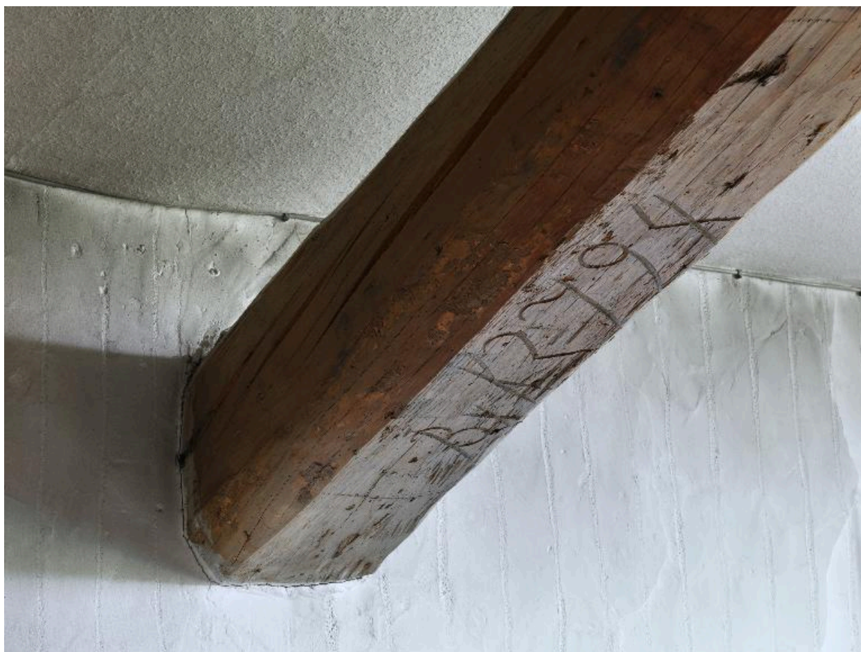
Ancienne grange, détail d'une poutre portant l'inscription 1794 (?)
