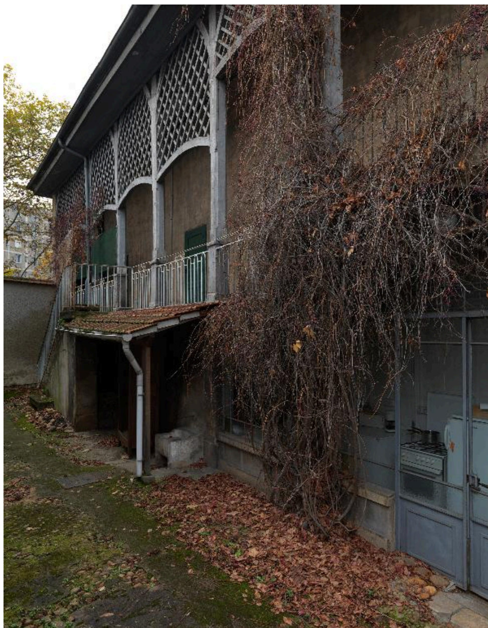
Maison de maître, élévation est, partie sud : fruitier et galerie en bois
