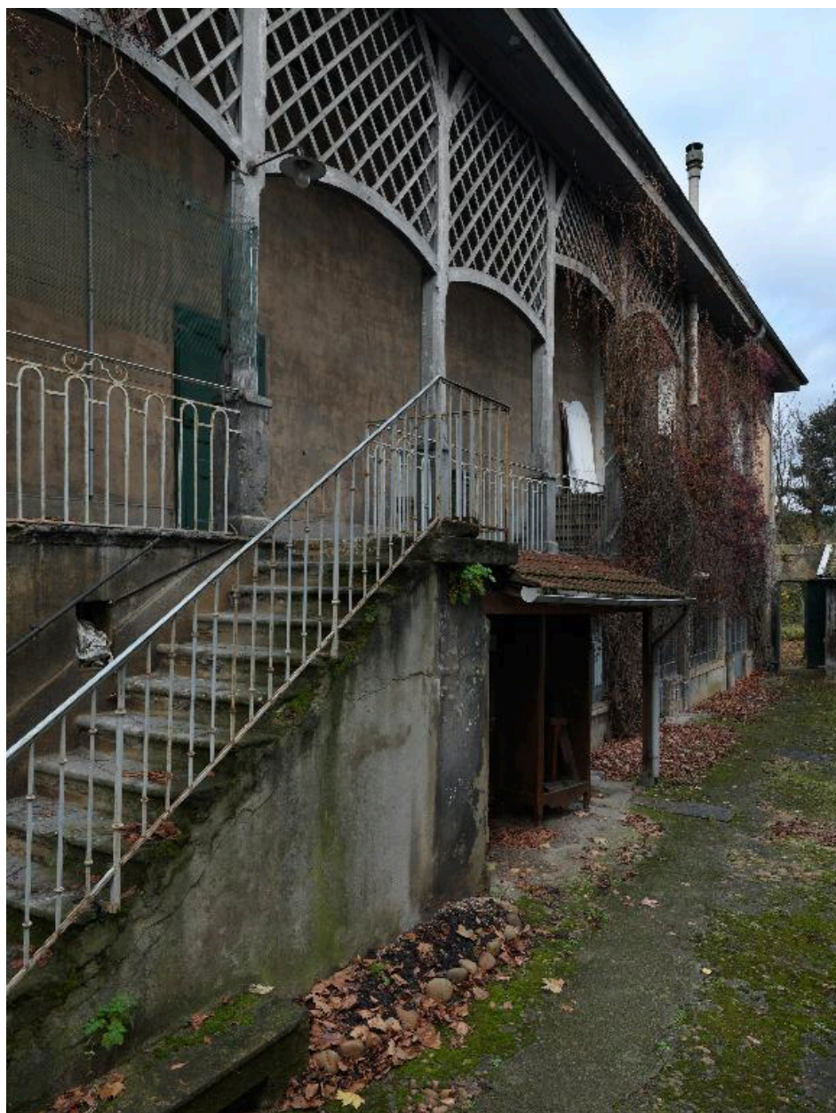
Maison de maître, élévation est, partie nord : véranda servant de cuisine, galerie en bois
