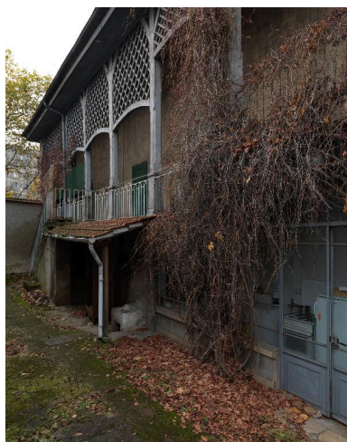
Maison de maître, élévation est, partie sud : fruitier et galerie en bois Phot. Thierry Leroy IVR84_20166902163NUCAQ
