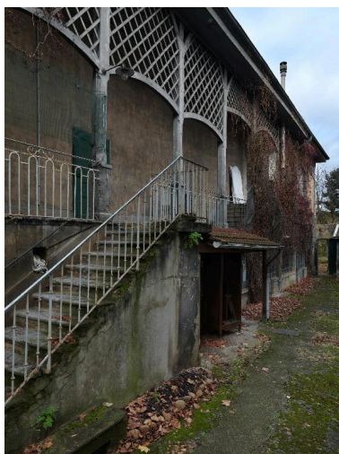
Maison de maître, élévation est, partie nord : véranda servant de cuisine, galerie en bois Phot. Thierry Leroy IVR84_20166902170NUCAQ
