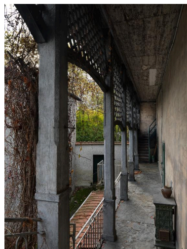
Galerie, vue depuis le nord Phot. Thierry Leroy IVR84_20166902173NUCAQ
