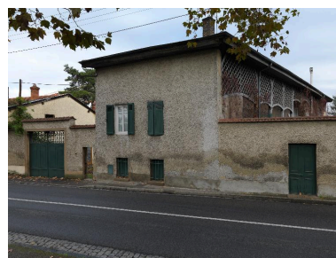
Maison de maître, depuis le sud-est Phot. Thierry Leroy IVR84_20166902154NUCAQ
