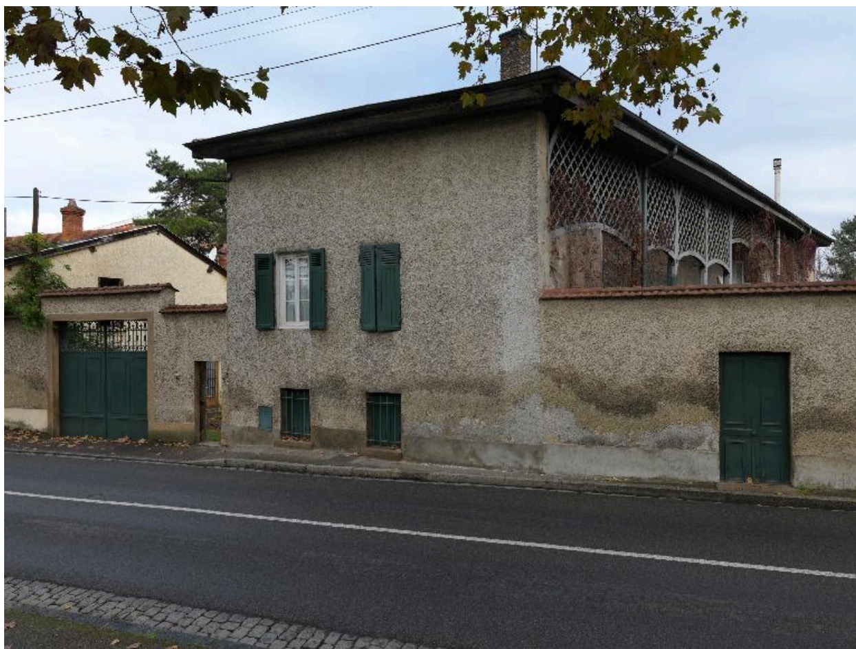
Maison de maître, depuis le sud-est
