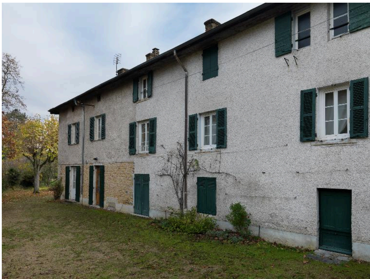
Maison de maître, élévation ouest
