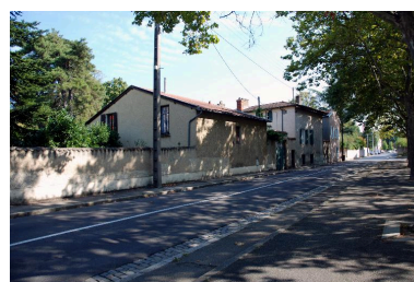
Vue générale depuis l'ouest Phot. Catherine Guégan IVR84_20166901688NUCA
