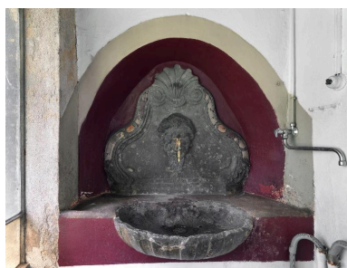
Vue rapprochée de la fontaine, au rez-de-chaussée de la galerie Phot. Thierry Leroy IVR84_20176902048NUCAQ
