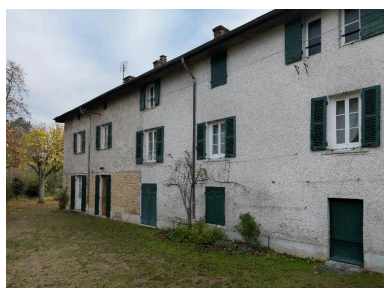
Maison de maître, élévation ouest Phot. Thierry Leroy IVR84_20166902157NUCAQ
