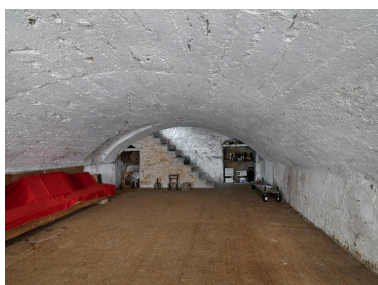
Maison de maître, partie nord : cave voûtée en berceau Phot. Thierry Leroy IVR84_20176902054NUCAQ
