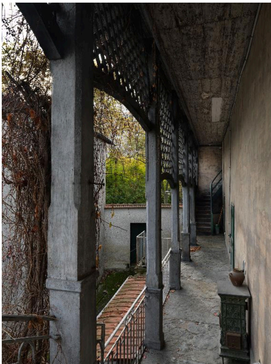
Galerie, vue depuis le nord
