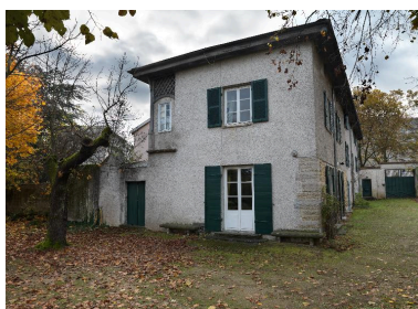
Maison de maître, depuis le nord-ouest Phot. Thierry Leroy IVR84_20166902161NUCAQ
