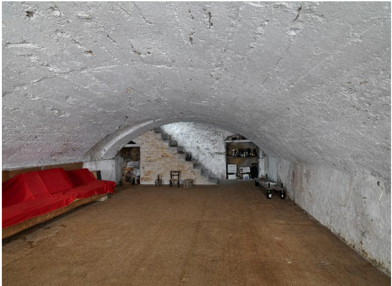
Maison de maître, partie nord : cave voûtée en berceau
