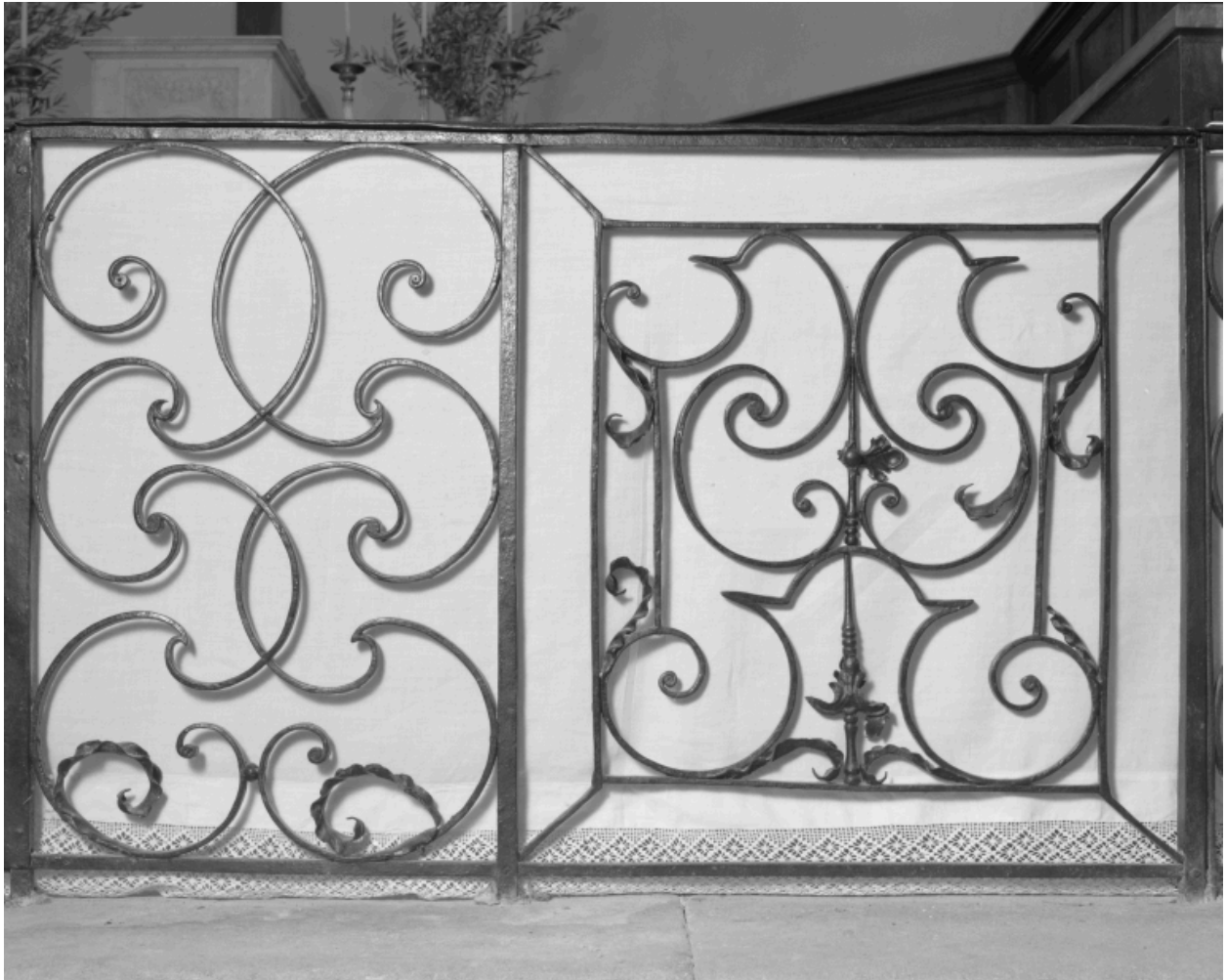
Détail d'une travée.
