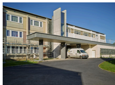
Façade est du bâtiment D2 : les travaux de reconstruction ont commencé. La cage d'ascenseur, en saillie, est un ajout au projet de G. Noël, de même que la salle en rez-de-chaussée et l'auvent.
