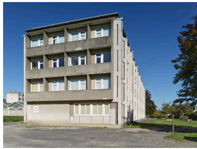
Pignon carré, à l'extrémité sud du bâtiment D1, avec loggias en avancée (correspondant aux chambres des surveillantes ?)
