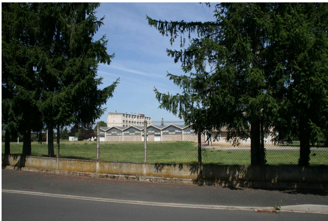
Depuis la rue Marie-et-Pierre-Curie, vue sur les gymnases et le bâtiment des logements de fonction. Clôture minimale
