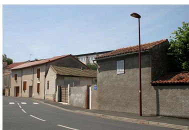
Le lycée, au second plan, derrière des maisons individuelles alignées sur la rue Marie-et-Pierre-Curie et antérieures à la construction du lycée Phot. Bénédicte Renaud-Morand IVR84_20224300062NUCA
