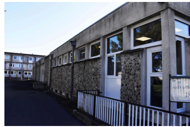
Angle nord-ouest du bâtiment des cuisines, en 2021. Effet de béton lavé, ou désactivé Phot. Bénédicte Renaud-Morand IVR84_20224300055NUCA
