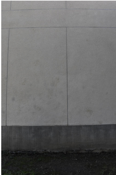
Détail du traitement de la surface du pignon nord du bâtiment D1 : béton strié en plinthe et effet de faux-joints en partie haute Phot. Bénédicte Renaud-Morand IVR84_20224300069NUCA
