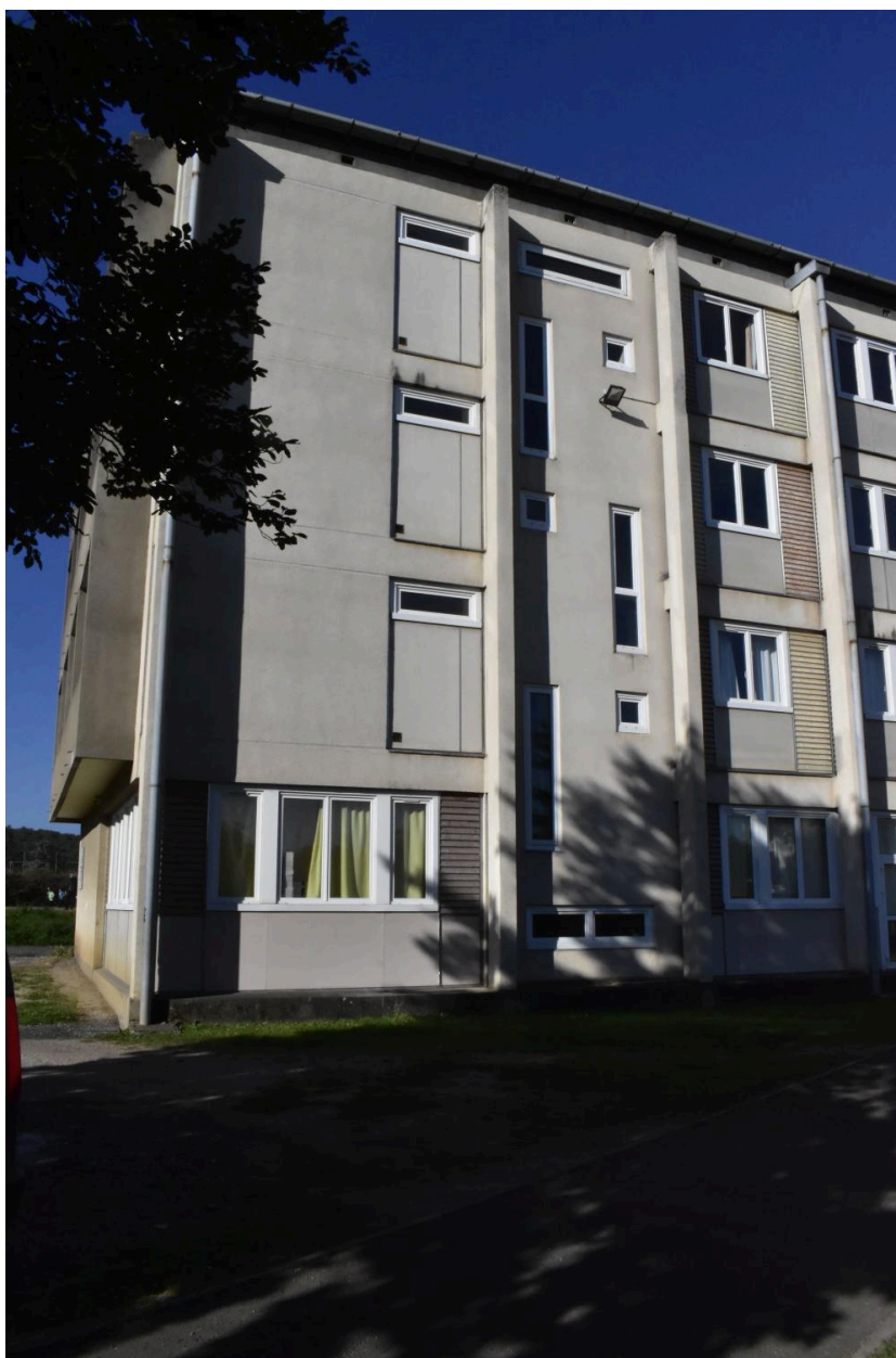
Bâtiment D1, extrémité sud : travée de la cage d'escalier (jeu de baies étroites de formats différents), travée des sanitaires (baies oblongues) et loggias en avancée sur le pignon
