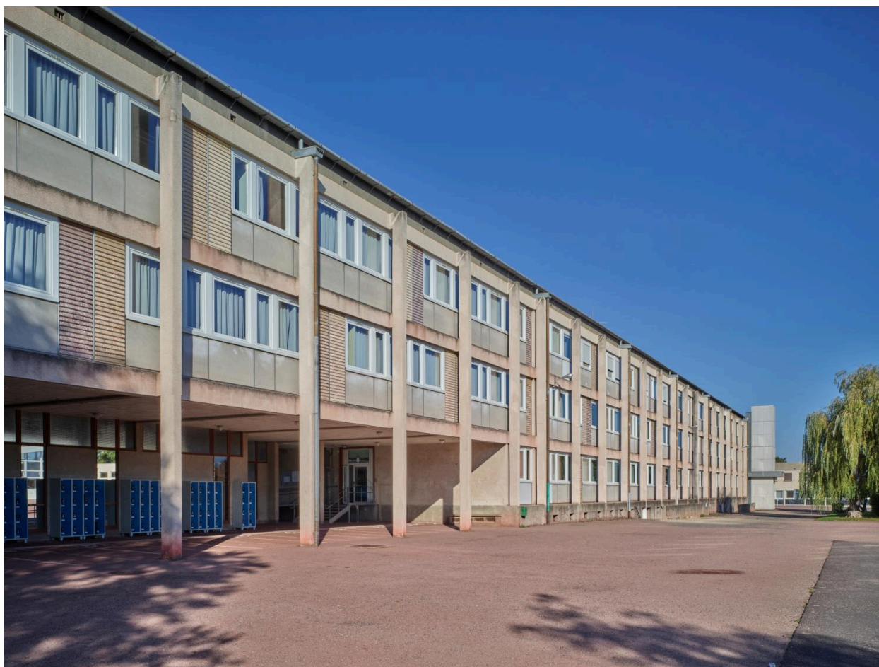
Bâtiment B : façade est vue depuis le sud, en 2021
