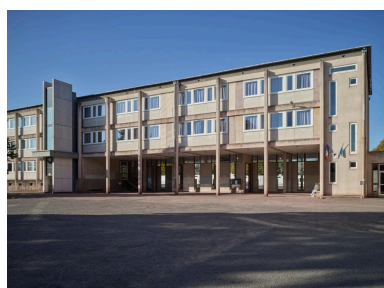
Extrémité nord du bâtiment principal (bâtiment B) ; la cage d'ascenseur en saillie de la façade est un ajout ; à droite, travée d'escalier avec son jeu de baies d'éclairement. Phot. Christian Parisey IVR84_20214300003NUC4A
