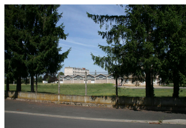
Depuis la rue Marie-et-Pierre-Curie, vue sur les gymnases et le bâtiment des logements de fonction. Clôture minimale Phot. Bénédicte Renaud-Morand IVR84_20224300060NUCA
