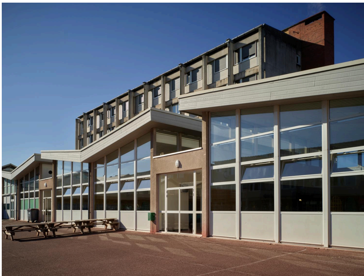
Cantine des élèves : façade est. À l'arrière-plan : bâtiment des logements de fonction avec effet d'ombres portées des poteaux auxquels est suspendu le mur-rideau.
