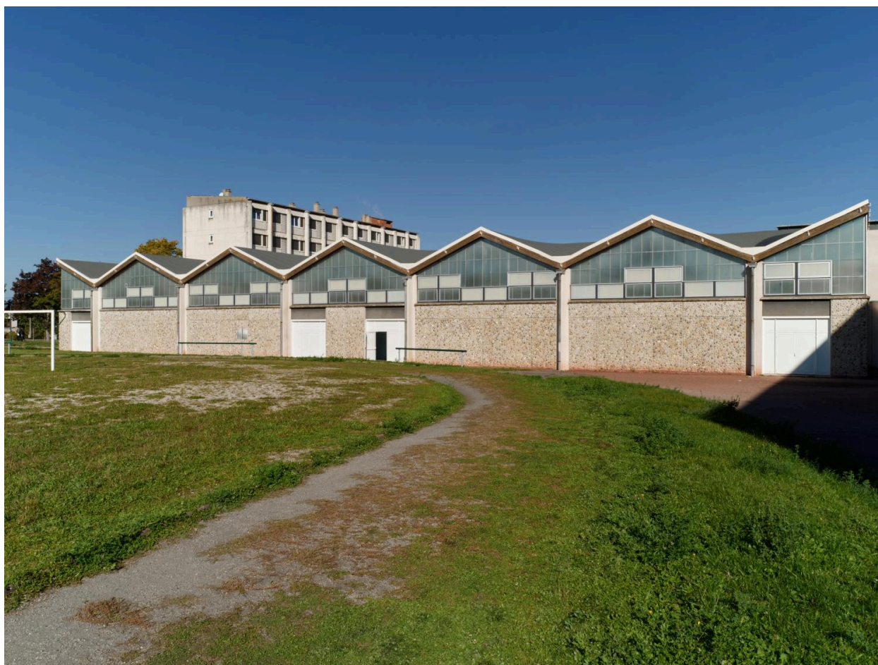
Élévation sud des deux gymnases, présentant un béton désactivé, en partie basse. À l'arrière-plan, bâtiment F des logements de fonction, en 2021
