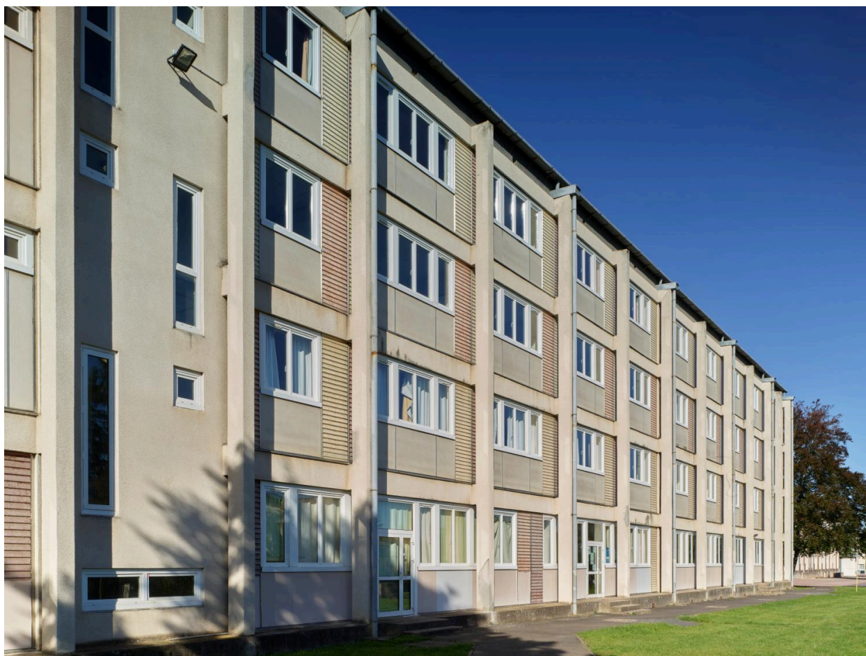
Bâtiment D1, façade est. Au premier plan, travée d'un escalier, puis poteaux en béton en avant de la façade, auxquels sont suspendus les murs-rideaux.
