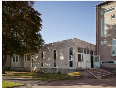
Jonction du bâtiment B, au nord, et du bâtiment D1, au sud. A l'origine, "hall d'entrée des filles", actuellement foyer des lycéens Phot. Christian Parisey IVR84_20214300008NUC4A
