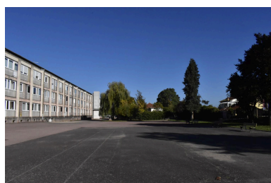
Bâtiment B et cour avec bancs. Système de cour anglaise pour accéder au sous-sol, en 2021 Phot. Bénédicte Renaud-Morand IVR84_20224300051NUCA
