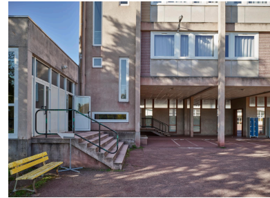
Au centre, travée de l'escalier A avec son jeu de baies d'éclairément (sud du bâtiment B). Les "mains courantes tubulaires" des deux degrés ont été dessinées par les architectes en 1962. Phot. Christian Parisey IVR84_20214300009NUC4A
