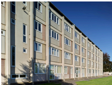
Bâtiment D1, façade est. Au premier plan, travée d'un escalier, puis poteaux en béton en avant de la façade, auxquels sont suspendus les murs-rideaux. Phot. Christian Parisey IVR84_20214300012NUC4A
