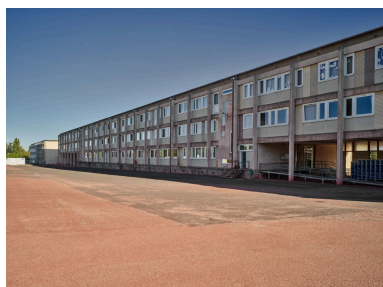
Bâtiment B, façade ouest. À l'arrière-plan, le bâtiment D2 (internat des garçons sur les plans d'origine), pour lequel les travaux d'isolation de la façade par l'extérieur ont commencé.
