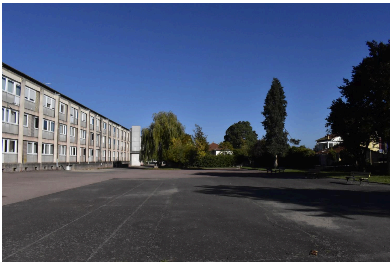
Bâtiment B et cour avec bancs. Système de cour anglaise pour accéder au sous-sol, en 2021
