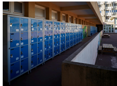
Partie basse de l'élévation du gymnase donnant sur la grande cour : couloir ouvert abritant les casiers des élèves.
