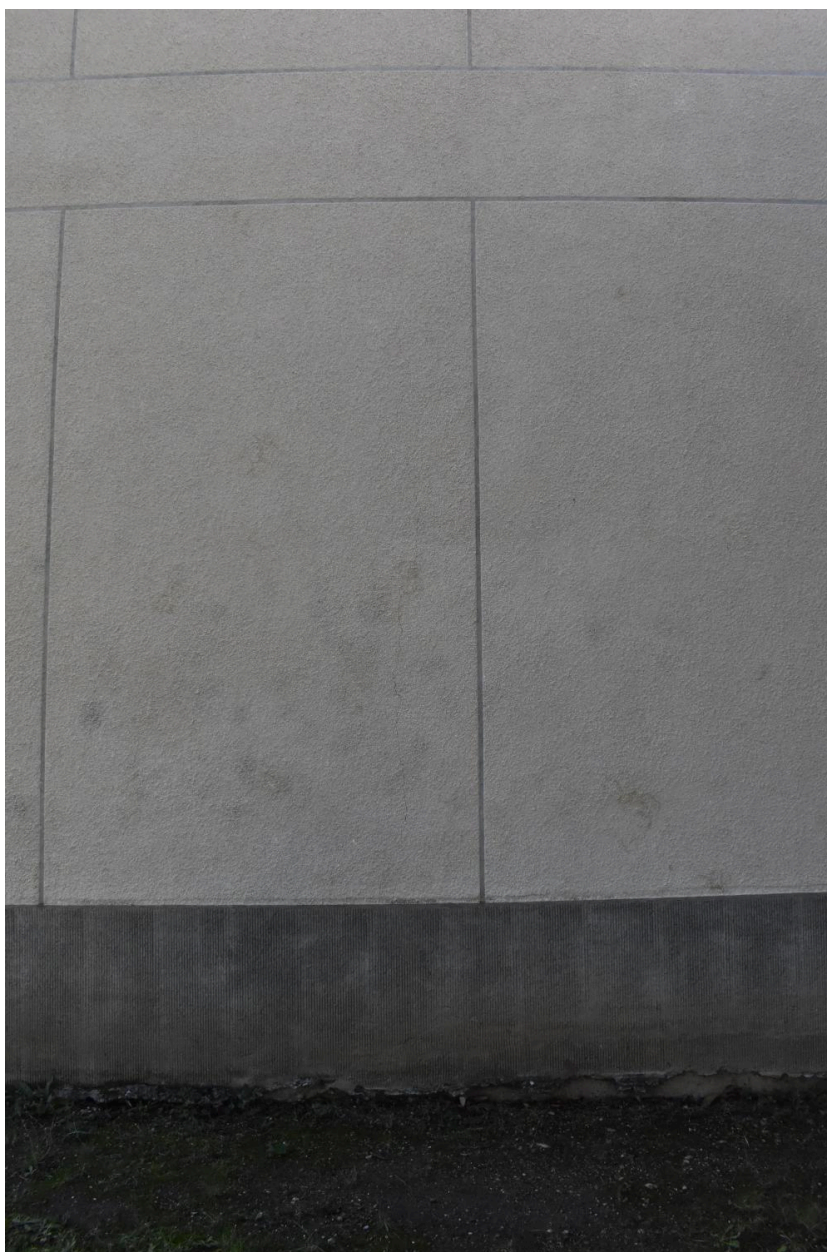
Détail du traitement de la surface du pignon nord du bâtiment D1 : béton strié en plinthe et effet de faux-joints en partie haute
