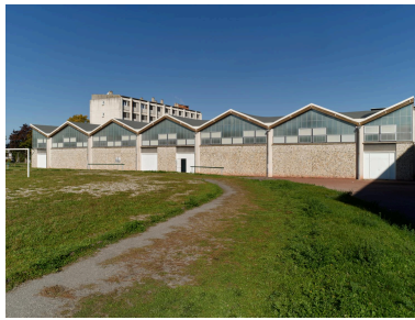
Élévation sud des deux gymnases, présentant un béton désactivé, en partie basse. À l'arrière-plan, bâtiment F des logements de fonction, en 2021
