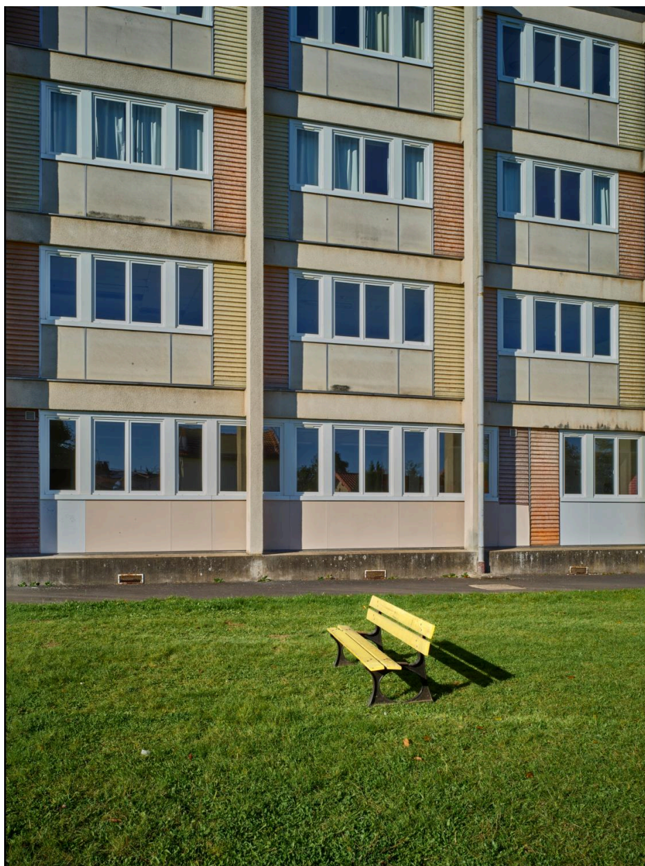
Bâtiment D1 : façade est, détail, en 2021
