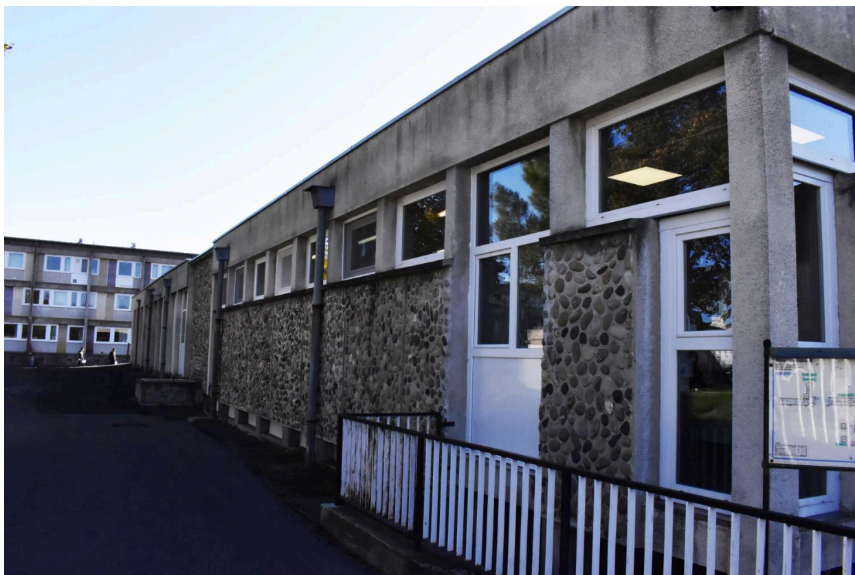
Angle nord-ouest du bâtiment des cuisines, en 2021. Effet de béton lavé, ou désactivé
