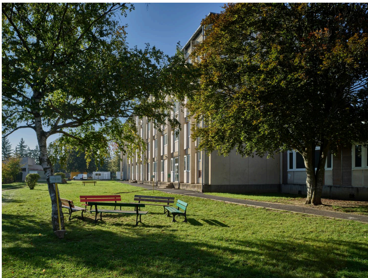
Bâtiment D1 (internat des filles à l'origine), abritant le GRETA au rez-de-chaussée, en 2021.
