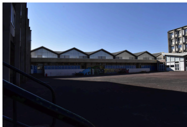
Les deux gymnases depuis le nord. Un couloir ouvert relie, le long des gymnases, la cantine (bâtiment E) aux gymnases et aux bâtiments D1 et B
