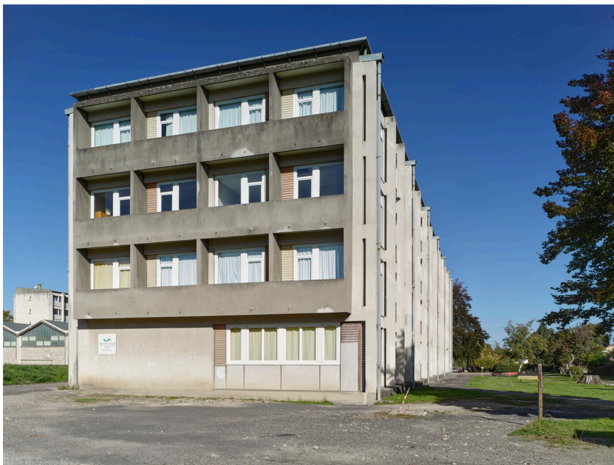
Pignon carré, à l'extrémité sud du bâtiment D1, avec loggias en avancée (correspondant aux chambres des surveillantes ?)
