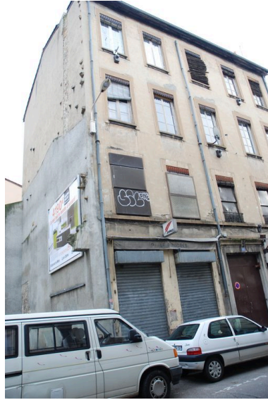
Vue oblique montrant le pignon ouest Phot. Catherine Guillot IVR82_20136900002NUCA
