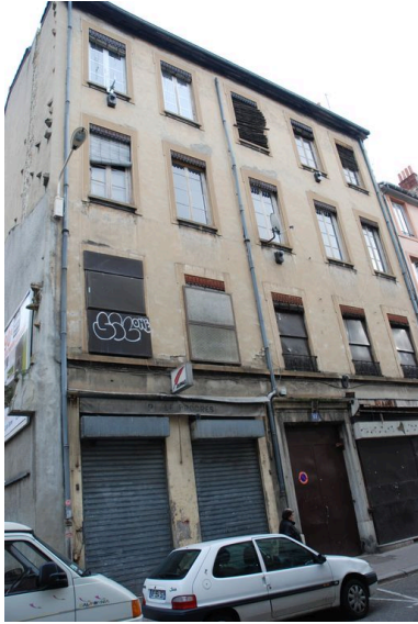
Elévation sur rue Phot. Catherine Guillot IVR82_20136900001NUCA
