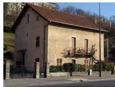
Façade sur rue Phot. François Fouger IVR82_20077300957NUCA
