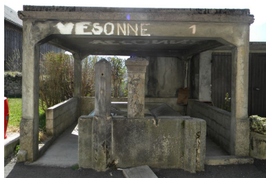
Vue générale Phot. Jérôme Daviet IVR82_20127400902NUCA
