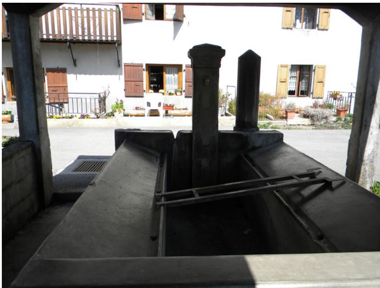
vue du lavoir sous sa couverture
