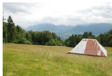
Vue générale depuis l'ouest.
