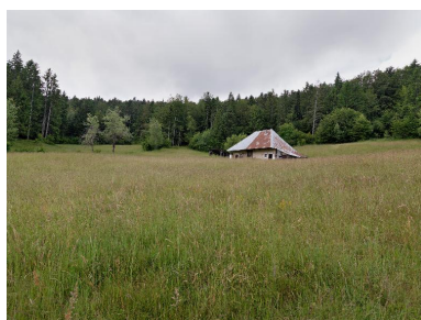
Vue générale. Phot. Eric Dessert IVR84_20167303679NUCA
