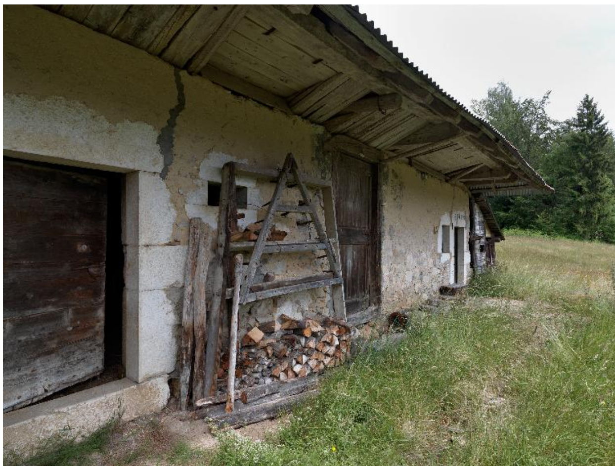
Vue de la façade.
