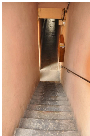
Vue de la première volée de l'esclaiier depuis le repos Phot. Nadine Halitim-Dubois IVR82_20146900341NUCA
