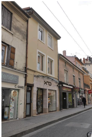
Vue d'ensemble nord ouest de l'immeuble de deux étages Phot. Nadine Halitim-Dubois IVR82_20146900335NUCA
