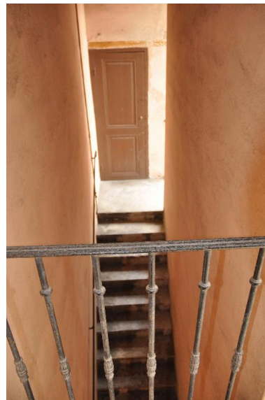
Vue de l'escalier depuis le dernier niveau Phot. Nadine Halitim-Dubois IVR82_20146900337NUCA
