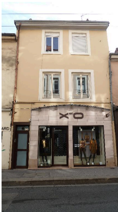
Vue ouest de l'immeuble Phot. Nadine Halitim-Dubois IVR82_20146900356NUCA
