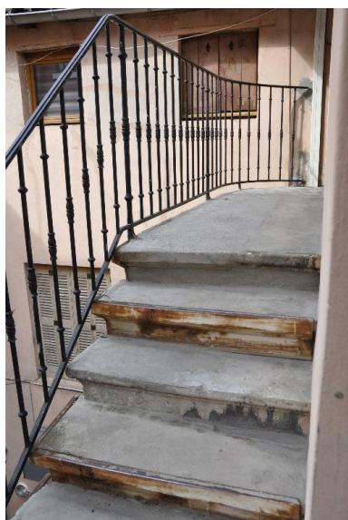
Vue du derniveau de l'escalier Phot. Nadine Halitim-Dubois IVR82_20146900339NUCA
