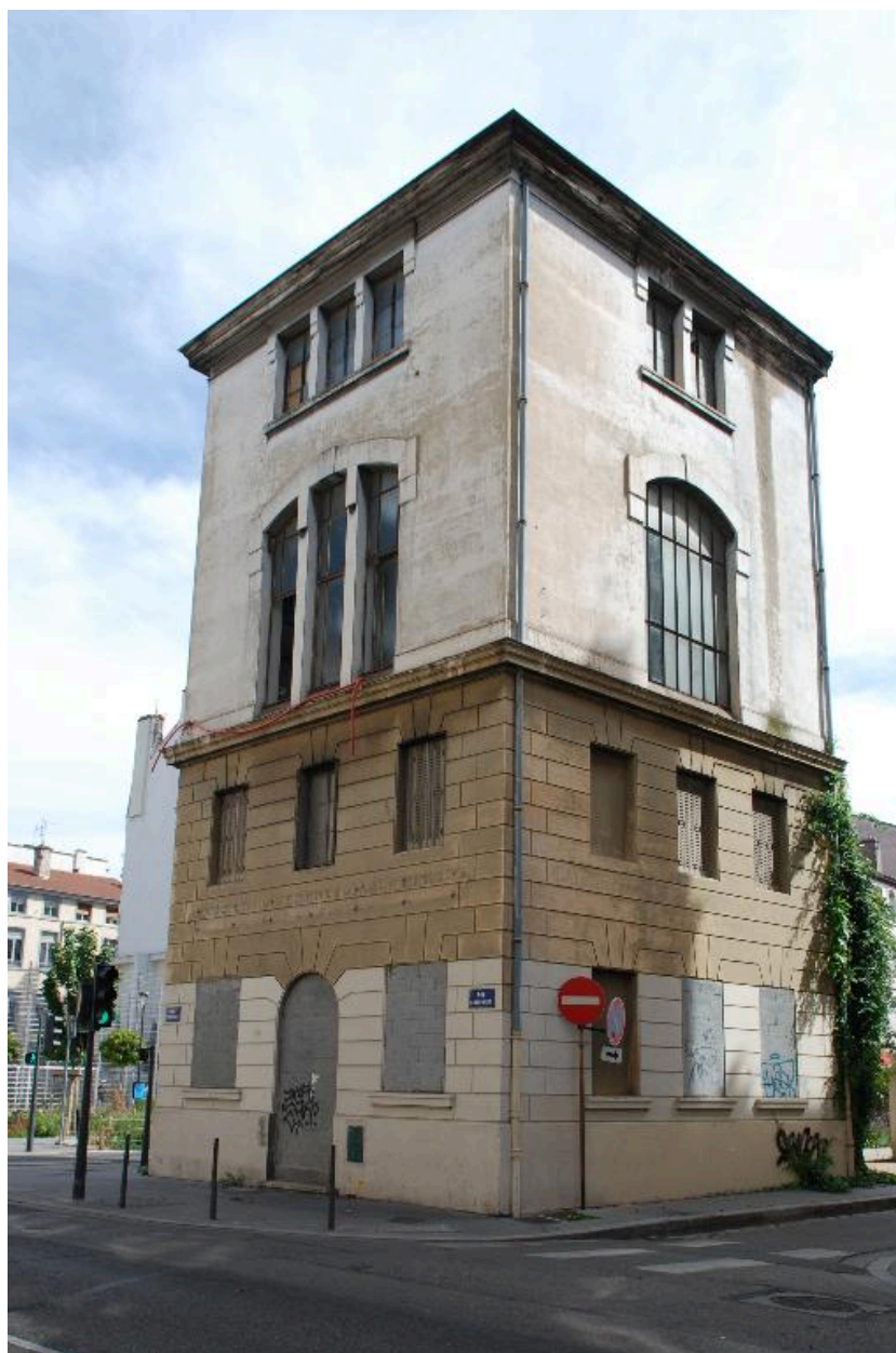
Vue générale depuis le nord-ouest
