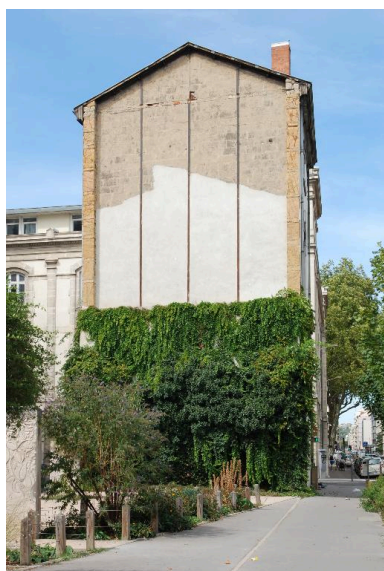
Vue de l'élévation sud mise à nu par la démolition des bâtiments adjacents Phot. Catherine Guégan IVR82_20156901105NUCA
