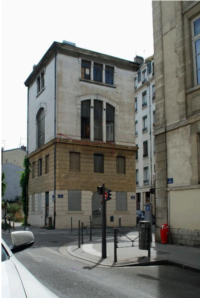
Vue générale depuis le nord-est : entrée sur la rue Chaponnay
