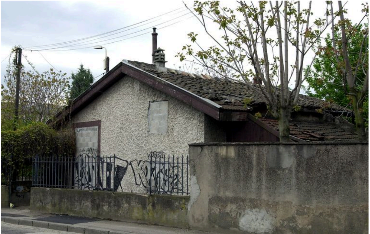
Vue générale depuis la rue Joannès-Carret
