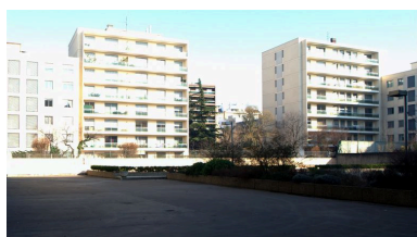
Elévation sur cour, depuis le sud Phot. Maryannick Chalabi IVR82_20116904134NUCA
