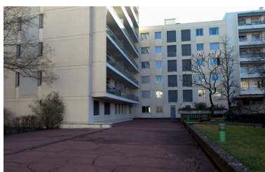
Elévation sur cour, vue partielle depuis l'ouest Phot. Maryannick Chalabi IVR82_20116904141NUCA
