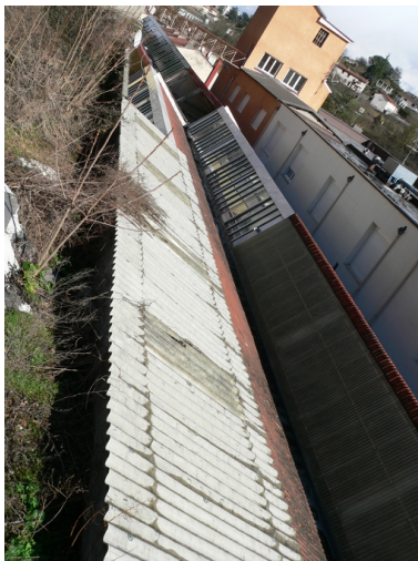
Sheds à l'arrière Phot. Isabelle Dupuis IVR82_20093800339NUCA
