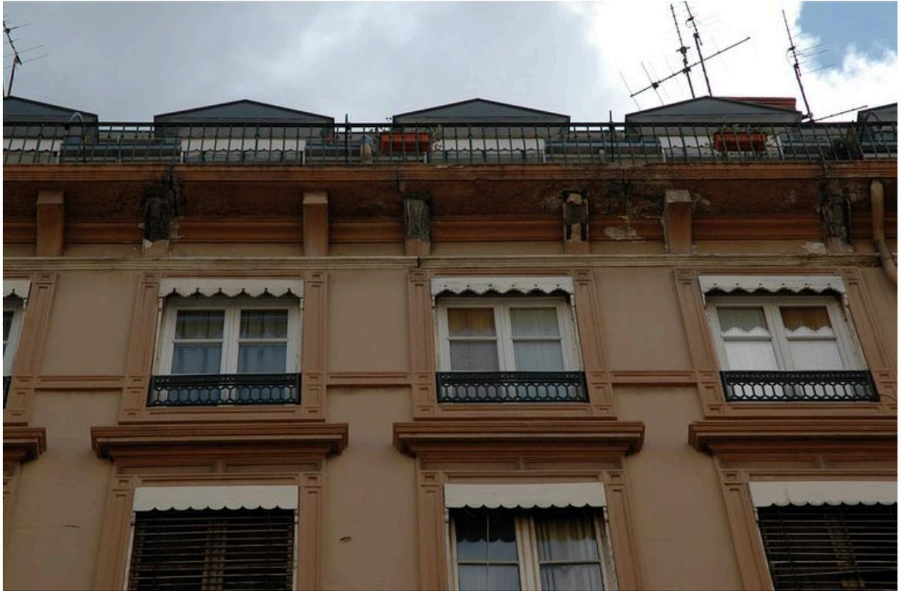
Elévation antérieure : détail de corbeaux en mauvais état
