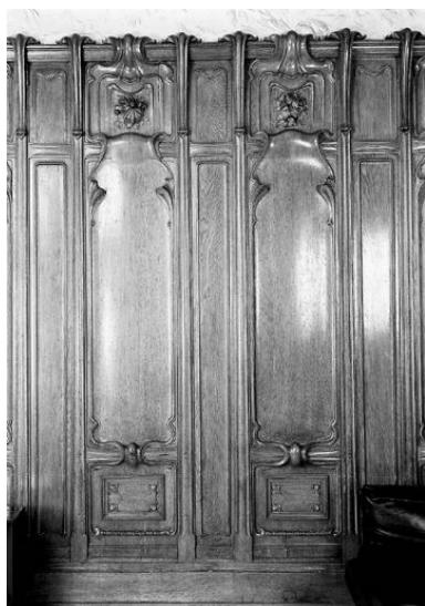
Vue partielle Phot. Jean-Marie Refflé IVR82_20016902815P
