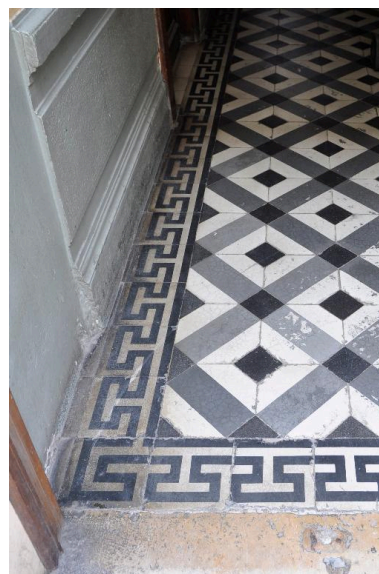
Vue intérieure : détail du pavement de l'allée Phot. Catherine Guégan IVR84_20176901082NUCA
