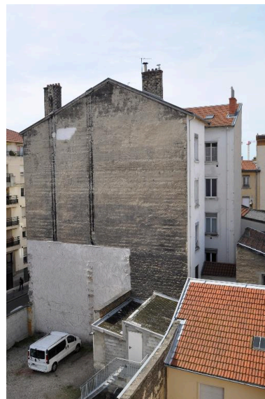
Vue d'ensemble, depuis le nord-est Phot. Catherine Guégan IVR84_20176901080NUCA
