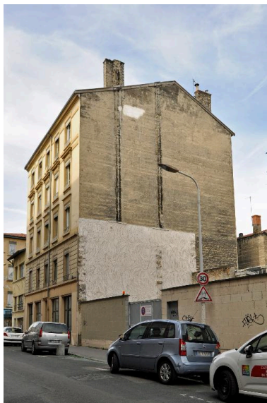
Vue d'ensemble, depuis le nord-est Phot. Catherine Guégan IVR84_20176901079NUCA
