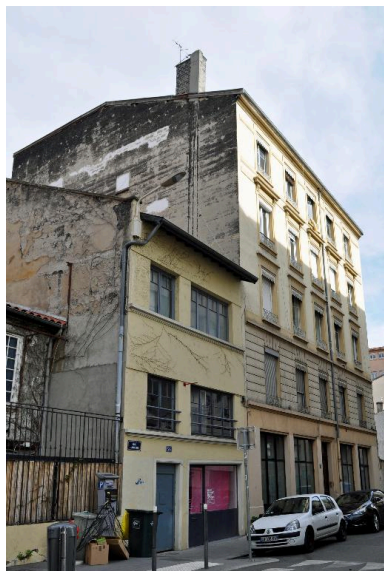
Vue d'ensemble, depuis le sud-est Phot. Catherine Guégan IVR84_20176901078NUCA
