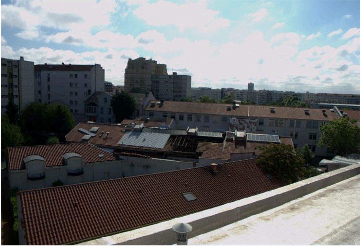
Vue des bâtiments depuis l'ouest
