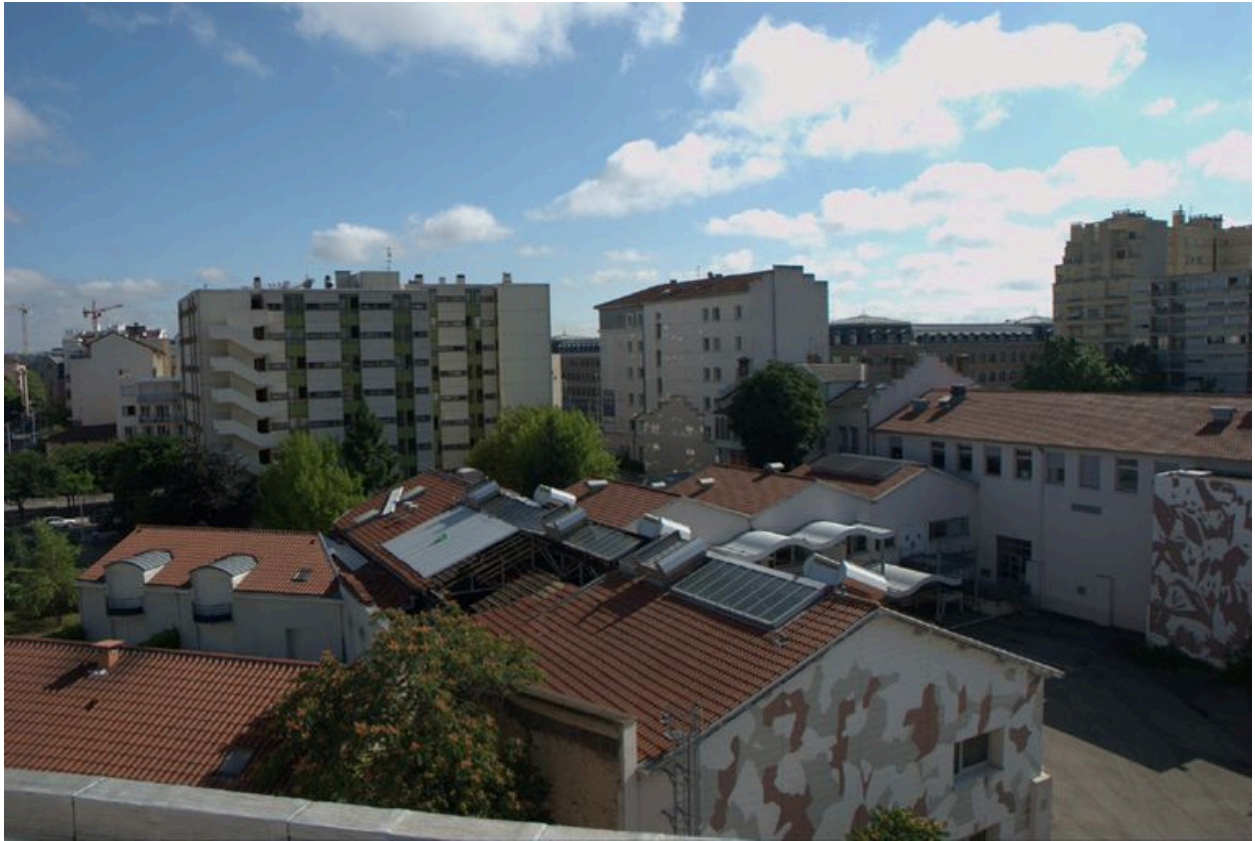
Vue des toits depuis le toit de l'immeuble 19 rue Claude-Veyron au sud-ouest
