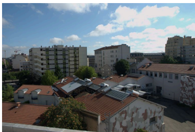
Vue des toits depuis le toit de l'immeuble 19 rue Claude-Veyron au sud-ouest Phot. M Chalabi IVR82_20086900871NUCA
