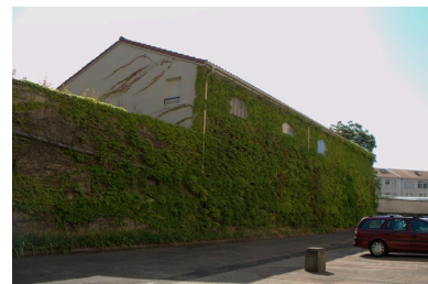
Elévation sud-ouest Phot. Maryannick Chalabi IVR82_20086900893NUCA
