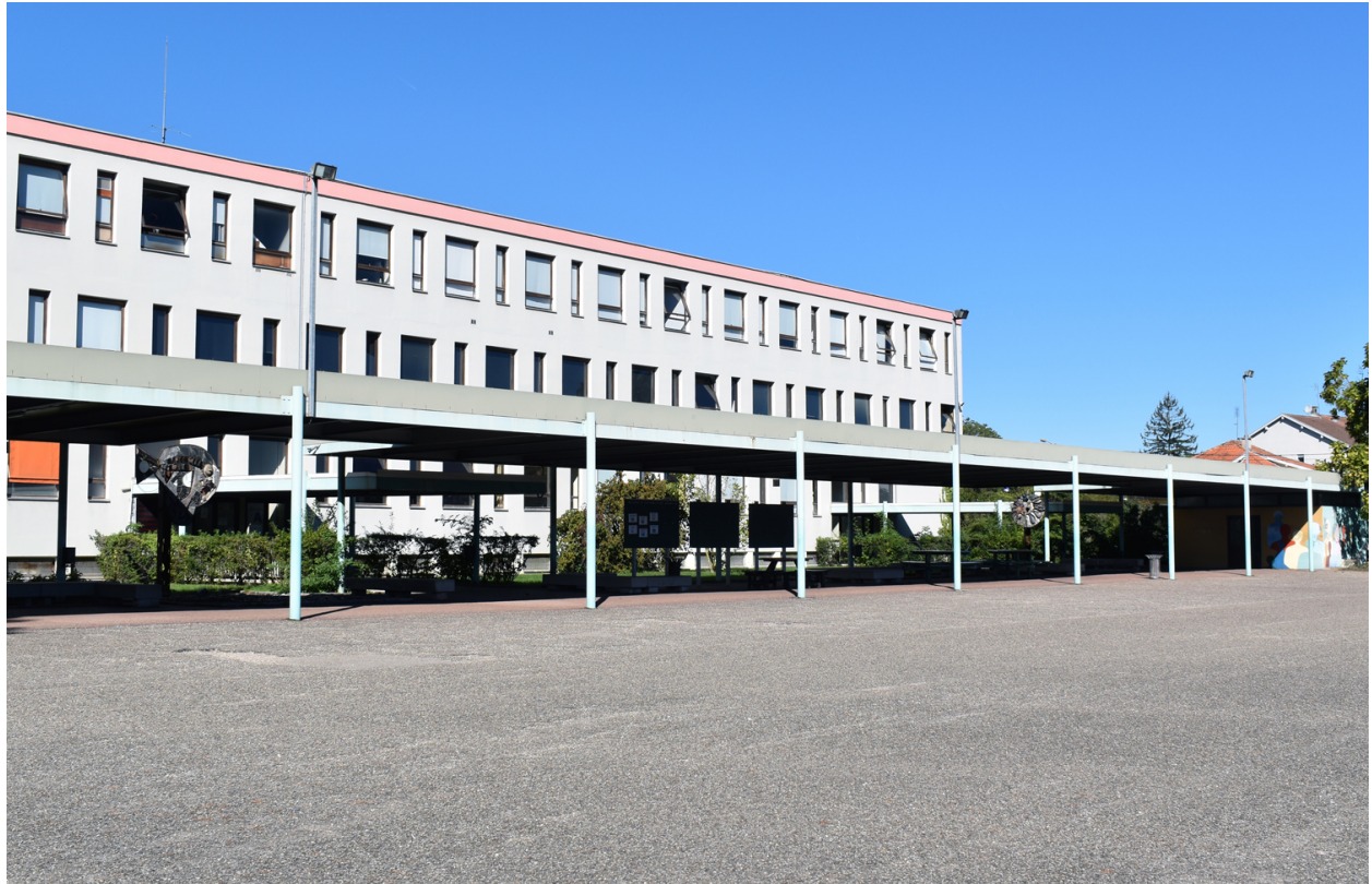
Vue d'ensemble des deux sculptures sous le préau du bâtiment A
