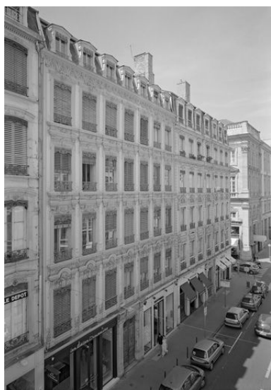
Façade, vue générale Phot. Eric Dessert IVR82_20056901728P
