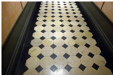
Sol de l'allée Phot. Bernard Ducouret IVR82_20046900262NUCA
