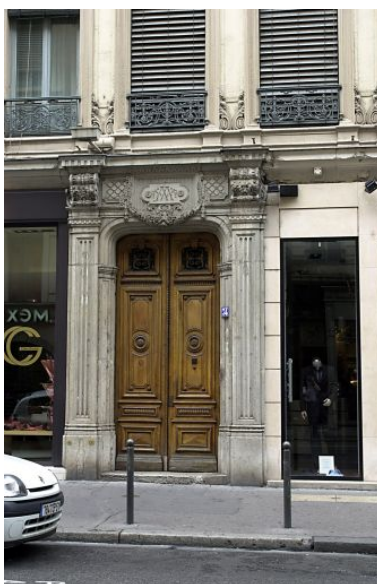
Façade, porte Phot. Bernard Ducouret IVR82_20046900253NUCA
