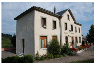
Vue d'ensemble. Phot. Thierry Monnet IVR84_20177301337NUCA
