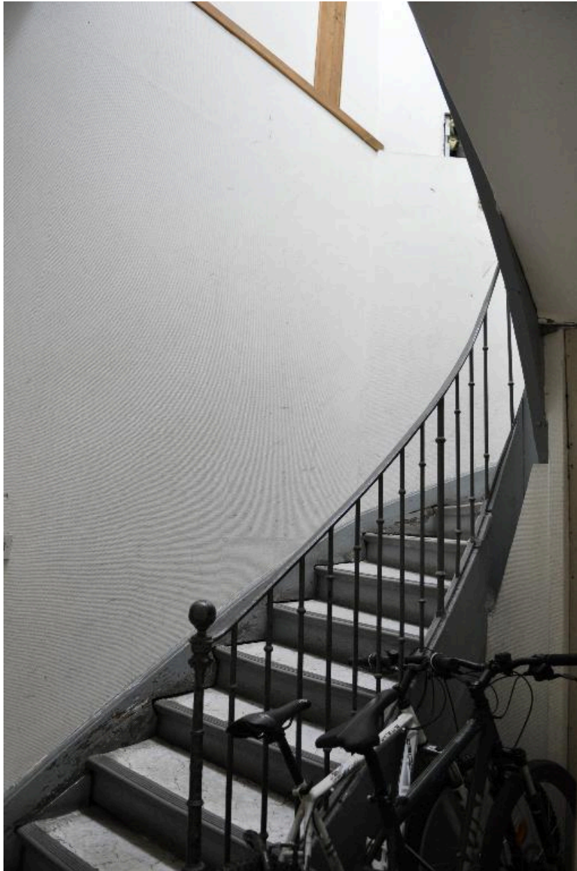
Immeuble sur cour, vue intérieure : l'escalier
