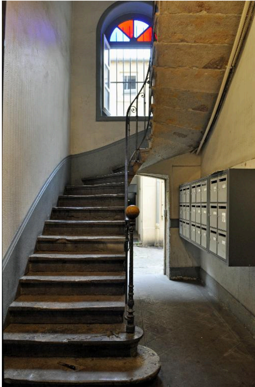
Immeuble sur rue, vue intérieure : le départ de l'escalier
