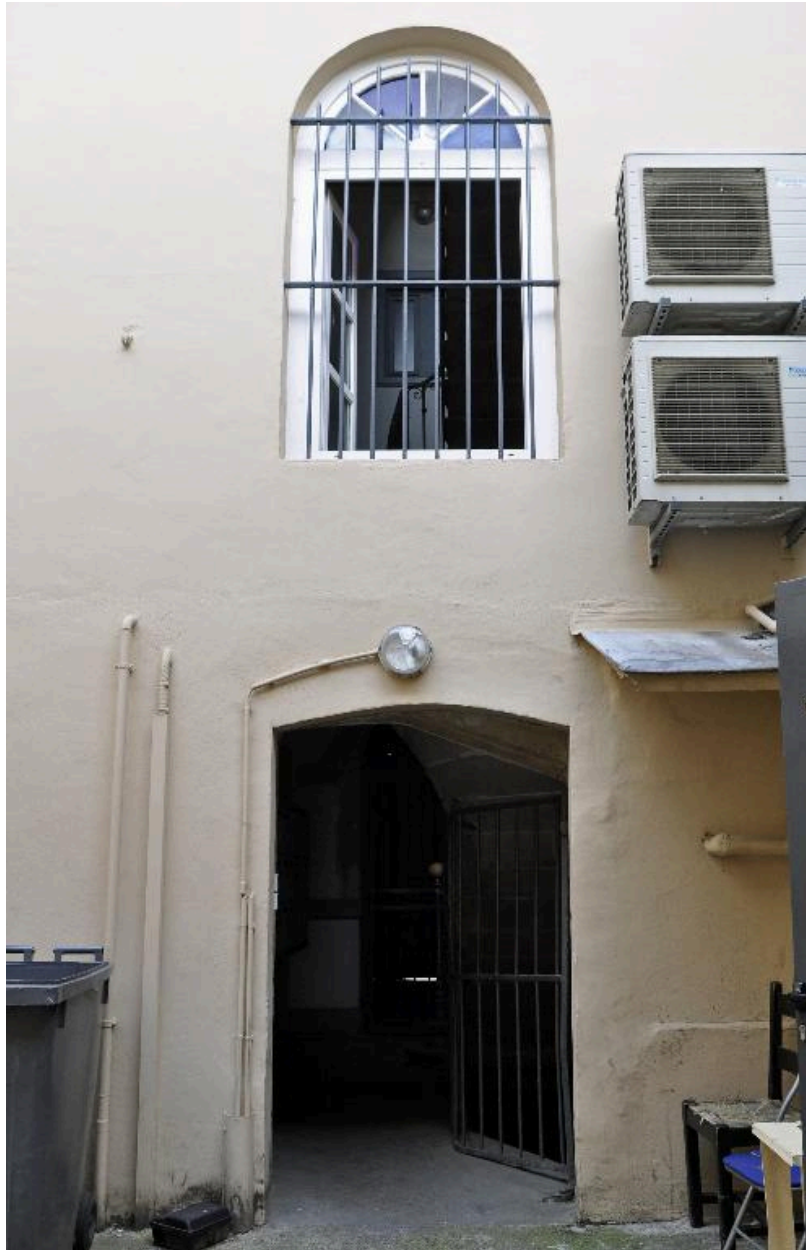
Immeuble sur cour, vue rapprochée de la travée centrale
