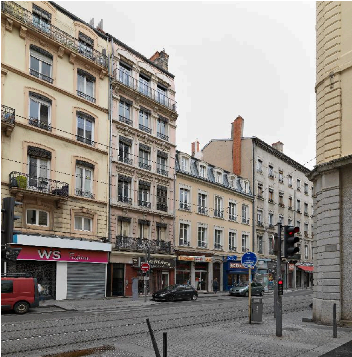
Vue de situation au sein de l'ilot
