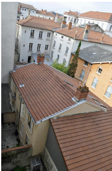
Immeuble sur cour, vue générale Phot. Catherine Guégan IVR82_20156901143NUCA
