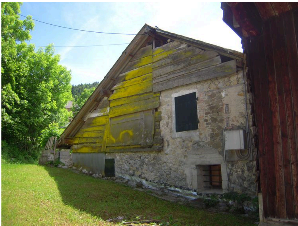
Vue de la façade nord.
