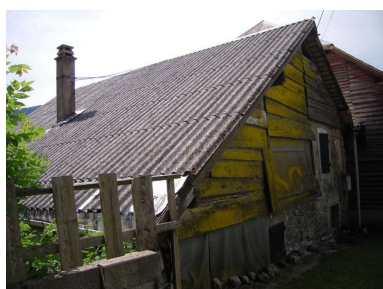
Vue de l'angle nord-est. Phot. Clémence Serve IVR82_20117400880NUCA
