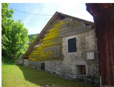
Vue de la façade nord. Phot. Clémence Serve IVR82_20117400881NUCA
