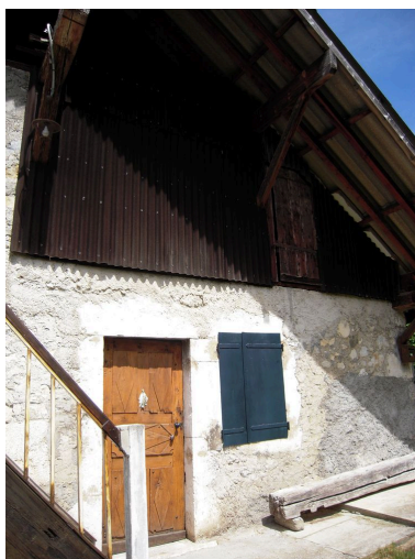
Vue de la façade sud. Phot. Clémence Serve IVR82_20117400878NUCA
